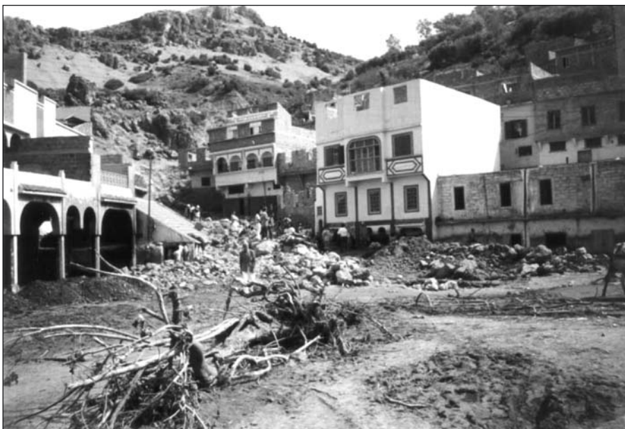
Photo 1. Vue vers le sud-est (6 août 1994). El Kebab au niveau d'Issighiden, le plus important torrent traversant l'agglomération. Le torrent est canalisé à partir de son entrée dans l'agglomération, mais le canal est peu entretenu. Les débordements provoqués par l'averse du 5 août 1994 ont causé des dégâts considérables. Au premier plan, la route est encombrée de matériaux divers. En arrière-plan, on observe le rebord du Causse d'El Kebab (cliché MD El Jihad).
