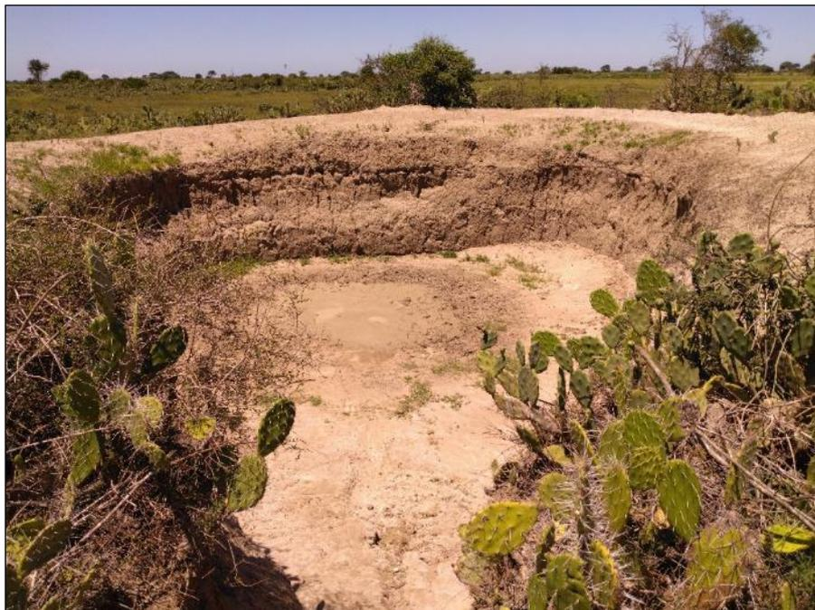
Figure 11: Réservoir creusé à la main pour stocker l'eau pluviale
