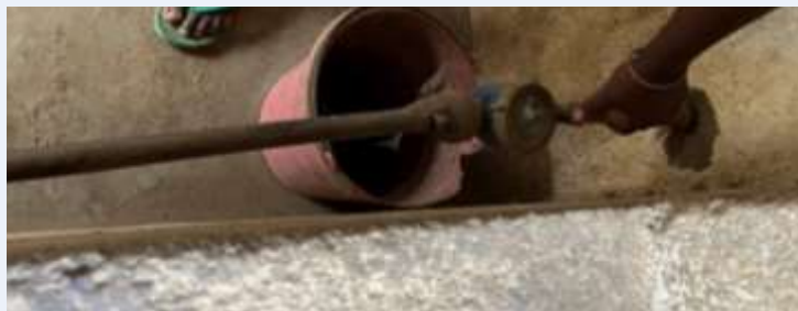
Figure 14 - Compteur sur une borne fontaine.
