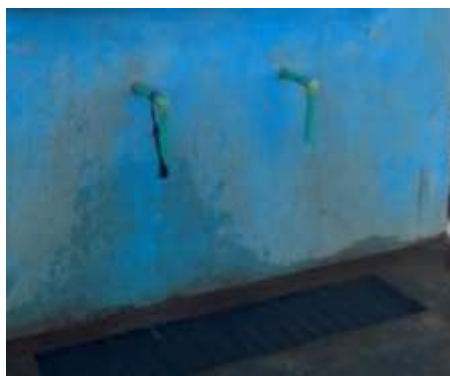
Figure 17 – Photo d'une BF sur laquelle un fontainier a mis un bouchon.
