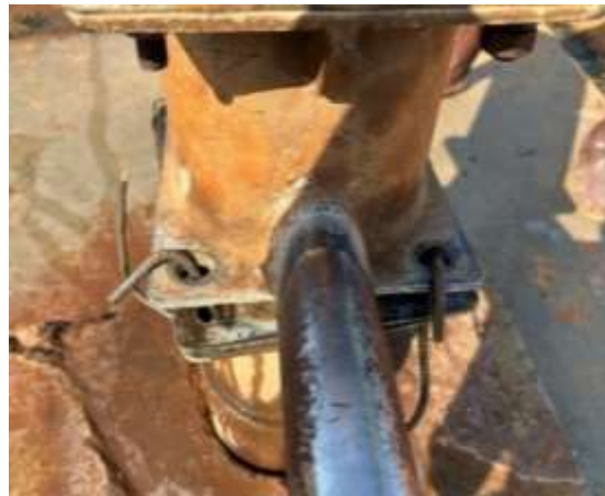
Figure 11 – Photo d'une tentative de réparation de PMH par les villageois. Les villageois ont utilisé du fil de fer comme solution provisoire et palliative au manque de vis. Ils comptaient en acheter lors du jour de marché du chef-lieu le plus proche avec la somme collectée après la panne.
