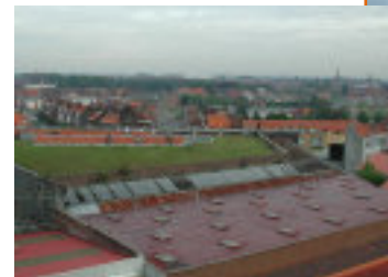
La végétation sauvage des toitures-terrasses a été conservée
