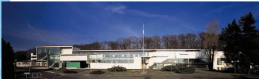
La façade sud de l'aile principale joue de pleins et de vides sous une toiture rectiligne
