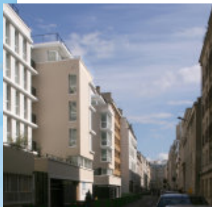
Placés à l'alignement, les deux immeubles de l'opération encadrent un jardin public
