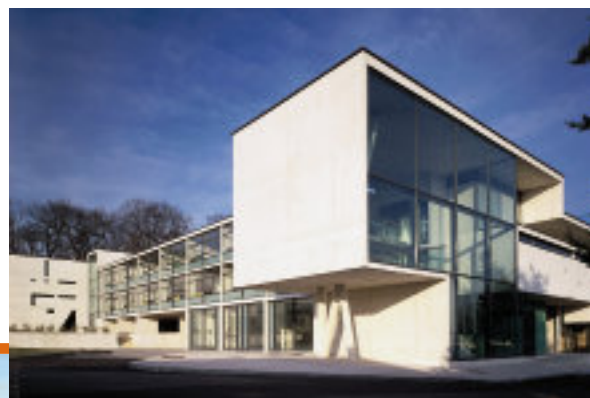
L'aile transparente de la pépinière d'entreprises, avec son hall d'accès, en premier plan
