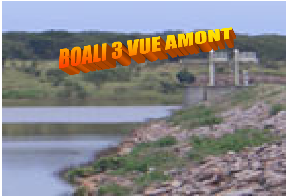
Image 2 : Barrage de Boali 3 sur la Mbali vue Amont
