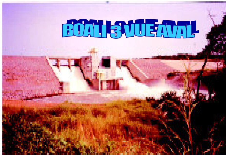
Image 3 : Barrage de Boali 3 sur la MBALI vue aval
