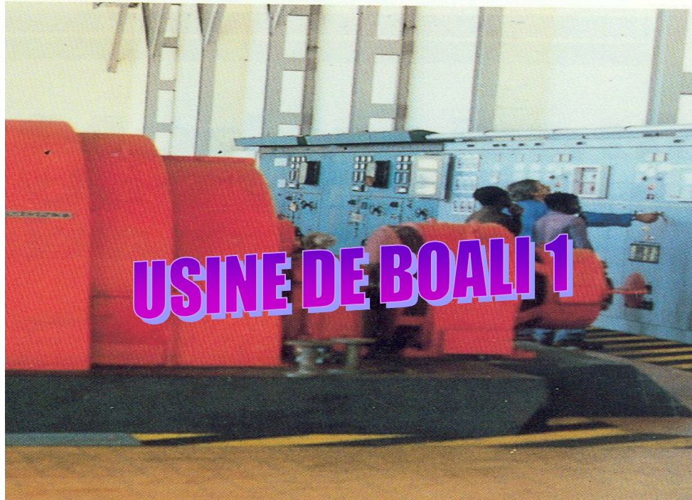
Image 1 : Une vue de l'usine hydroélectrique de Boali 1
