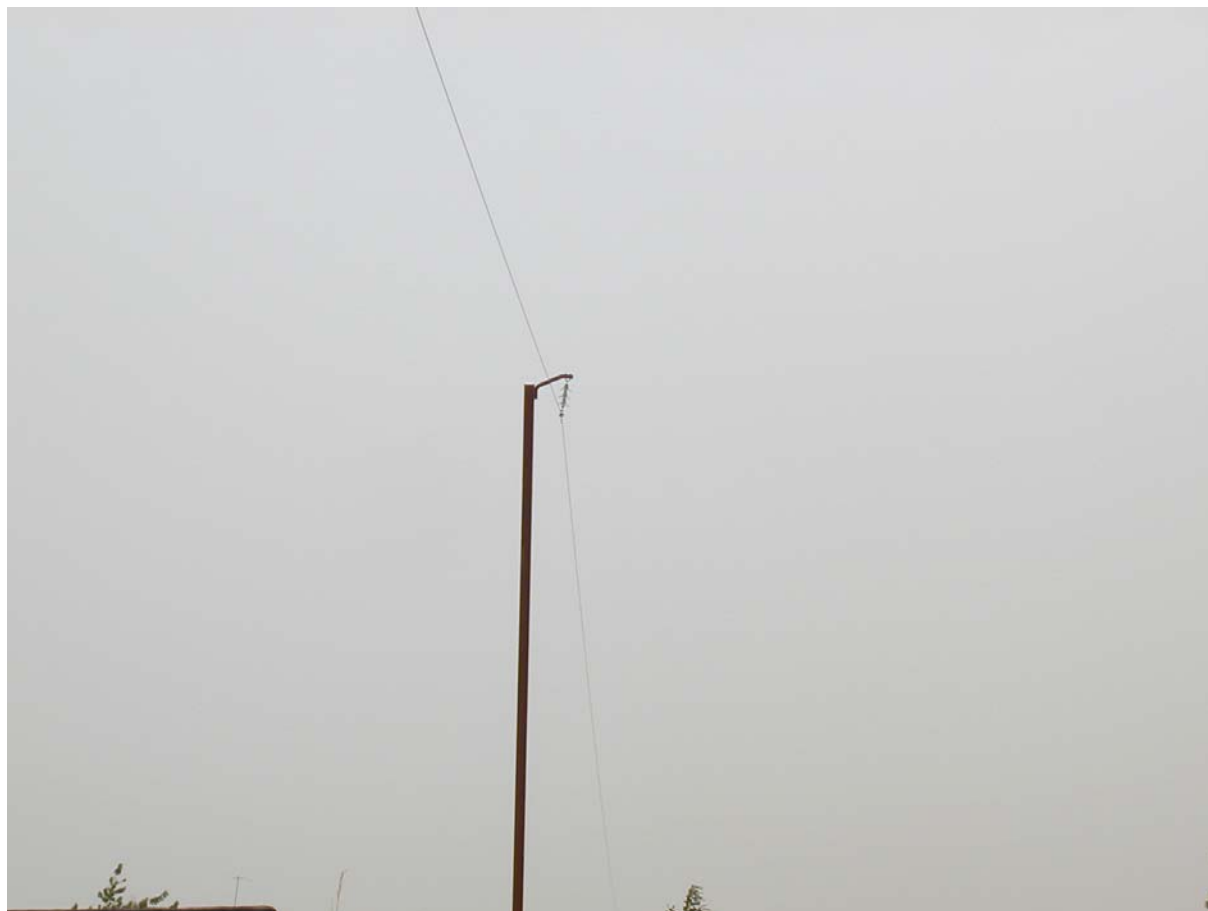
Support d'alignement SWER. Entre Garango et Béguédo
