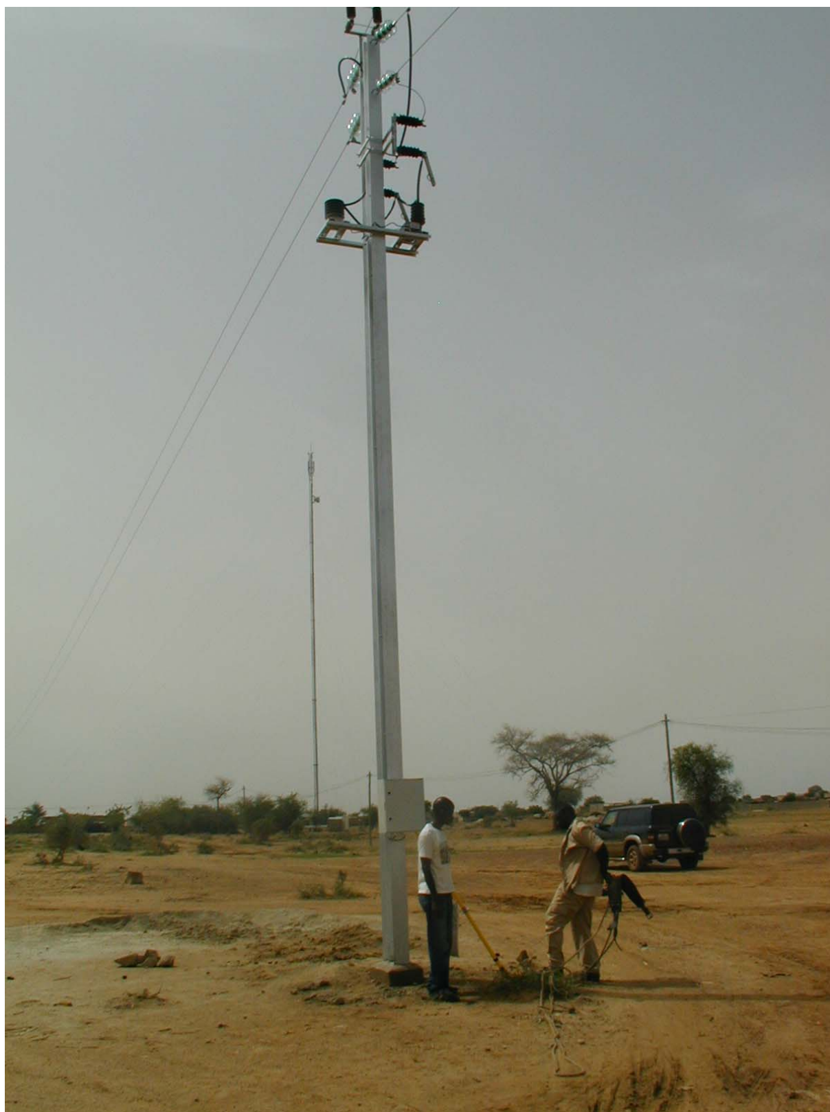
Poste de comptage. Béguédo
