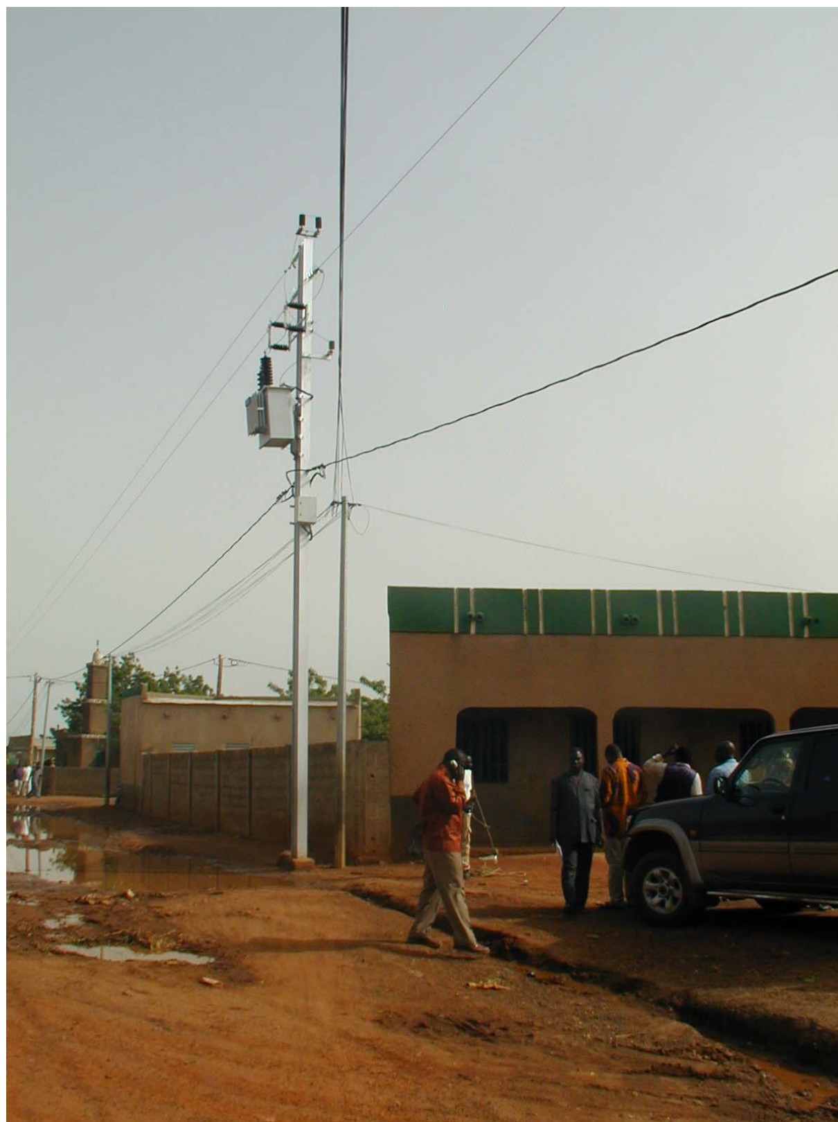
Poste de distribution. Béguedo
