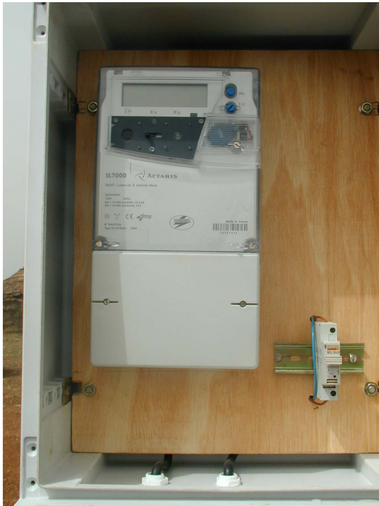
Poste de comptage. Béguédo
