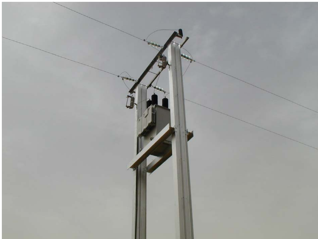
Transformateur d'isolement. Garango
