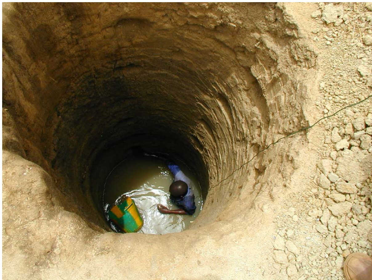
Puits de grand diamètre pour électrode verticale. Béguédo
