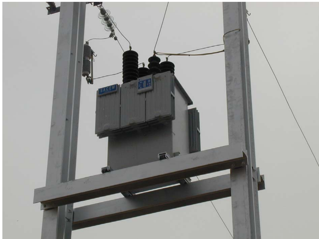
Transformateur d'isolement. Garango
