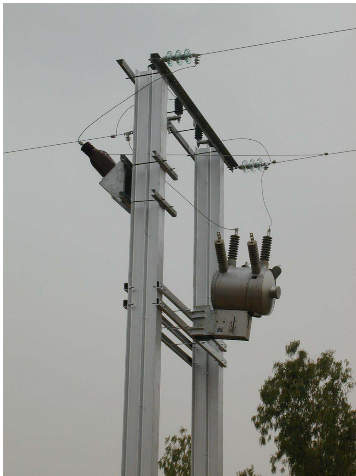
Disjoncteur triphasé utilisé comme monophasé. Garango
