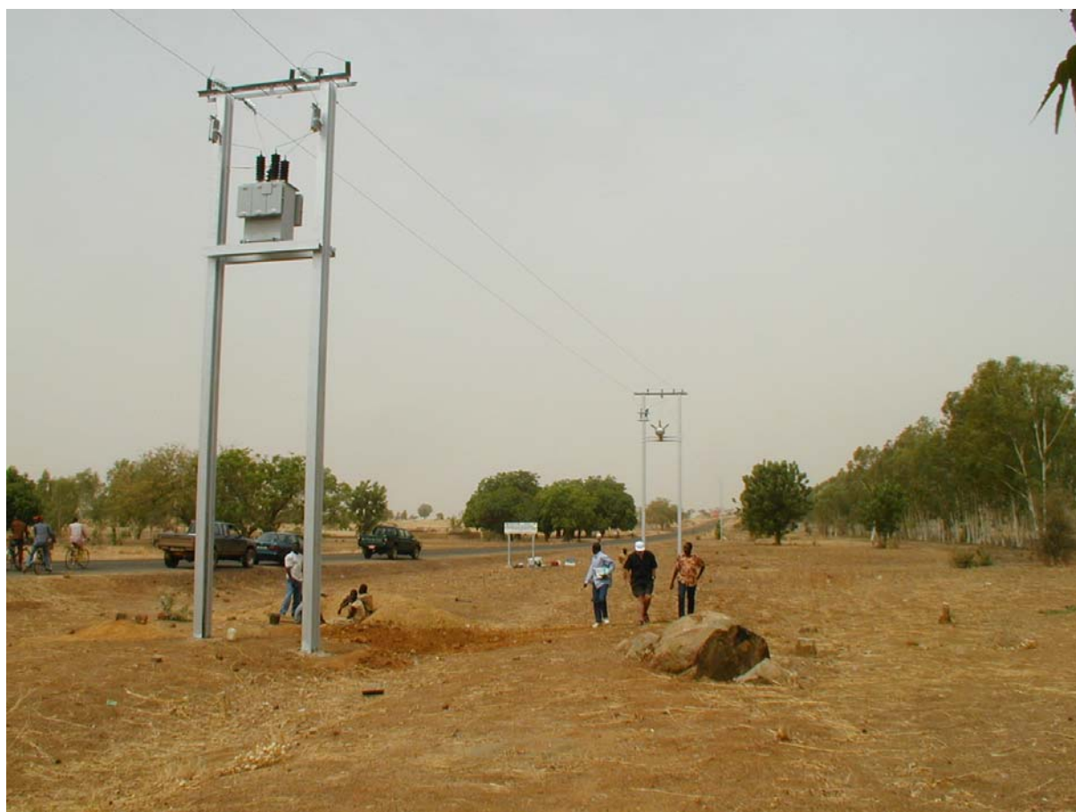
Transformateur d'isolement et, plus loin, disjoncteur SWER. Garango
