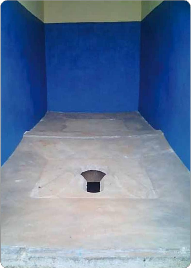
C'est une latrine avec plateforme en béton armé et munie d'une dalle sanplat ou en céramique intégrée. Elle est différente d'une toilette à la turque par le fait qu'elle ne comporte pas d'un dispositif de chasse d'eau et de siphon.
