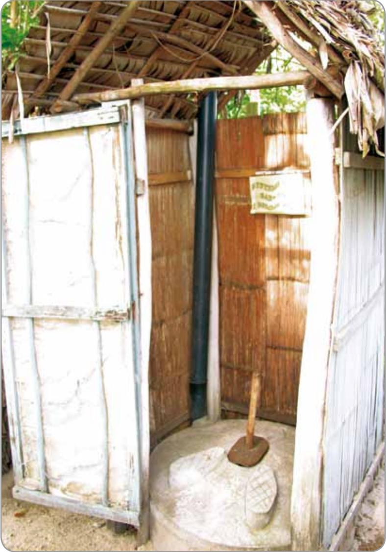
C'est une latrine avec plateforme circulaire en dôme et en béton légèrement armé comportant un trou et des pose pieds selon les modèles.
