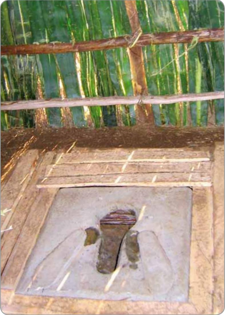
Il s'agit d'une dalle fabriquée à partir d'un moule dans lequel on coule du béton préalablement ferrillé. Lors de l'installation, la dalle sanplat est posée au dessus de la fosse sur des traverses en bois ou béton. Les abords sont ensuite recouverts d'un plancher de bois ou lissé.
