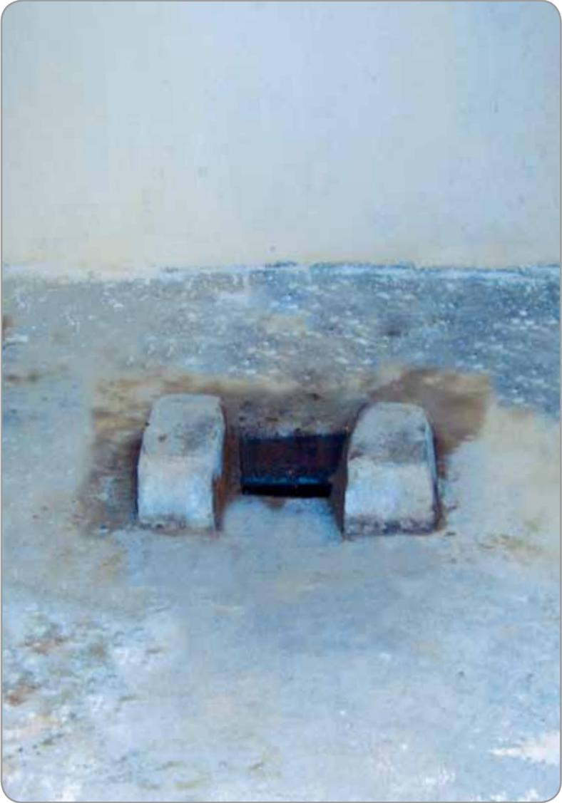
C'est une latrine avec plateforme rectangulaire en béton armé comportant un trou et des poses pieds selon les modèles.
