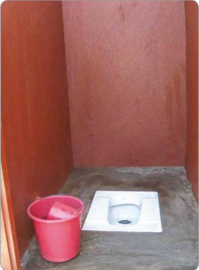
Elle consiste en un trou dans le sol, agencé d'une dalle en béton armé, muni de siphon ou non et rehaussée de pose pieds selon les modèles. Elle est équipée d'un dispositif de chasse d'eau, manuel ou mécanique. La plateforme d'une toilette à la turque peut être en céramique, en fibre de verre, en porcelaine ou en béton armé.
