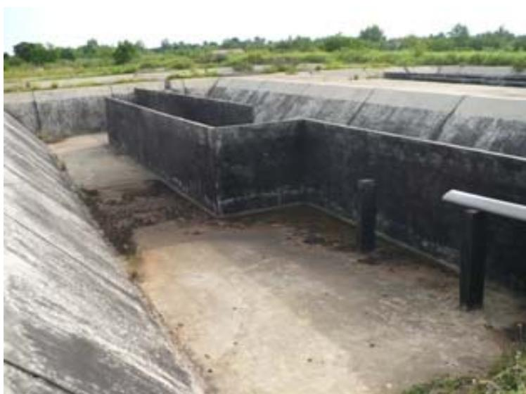
En milieu rural ou lorsqu'il n'existe pas encore de station de traitement des boues, un terrain clôturé peut être identifié et réservé à l'épandage des boues de vidange en surface ou en tranchées. Il faut s'assurer de ne pas polluer les eaux souterraines ou les eaux de surface par ruissellement.
