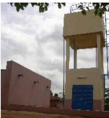
Le poste d'eau autonome est constitué d'un forage ou d'un puits équipé d'un système de pompage motorisé relié à un réservoir de stockage. L'eau est distribuée directement au pied du réservoir par une rampe comportant des robinets. L'eau doit ensuite être transportée sur les lieux de consommation par les usagers.
