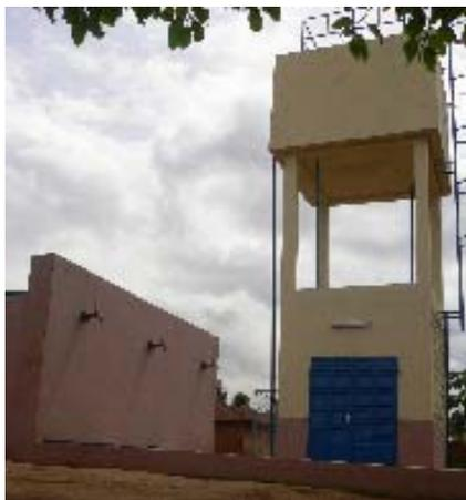
Le poste d'eau autonome est constitué d'un forage ou d'un puits équipé d'un système de pompage mécanisé relié à un réservoir de stockage. L'eau est distribuée directement au pied du réservoir par une rampe comportant des robinets. L'eau doit ensuite être transportée sur les lieux de consommation par les usagers.
