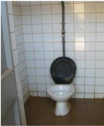
Figure 12 : Toilettes à chasse mécanique avec siège
