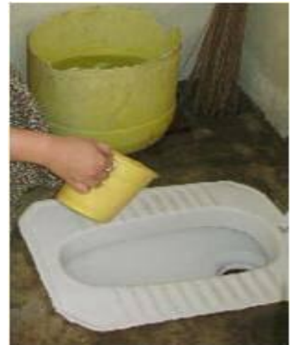
Figure 14 : Toilettes à chasse manuelle avec dalle en céramique
