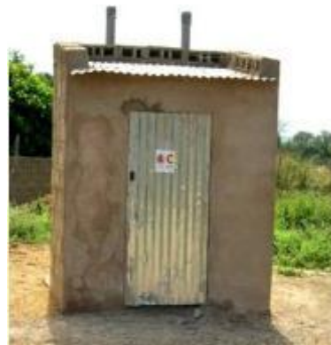
Figure 16 : Latrines à fosse ventilée (type VIP)
