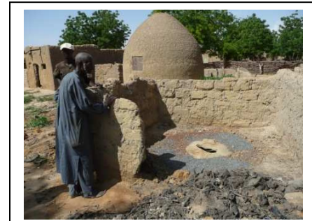
Latrines récemment vidangées avec boues de vidange au premier plan Badifa / région de Dosso
