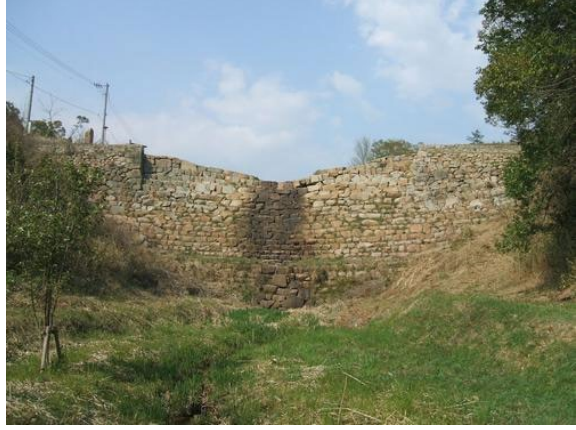
سد حجري في قاع النهر، حقوق الصورة: (2009) Carpkazu
