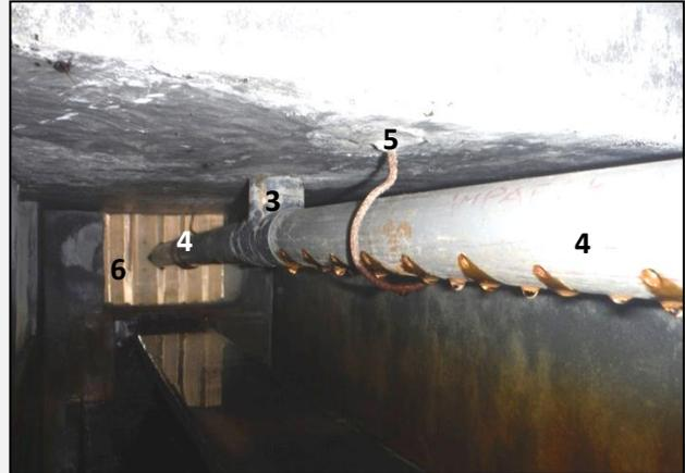
**Photo 2 : Attache du tuyau de rampe d'aération**
