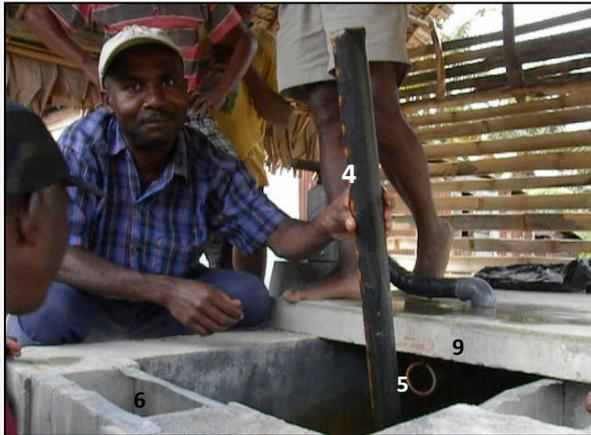
**Photo 1 : Relève du tuyau de rampe d'aération**
