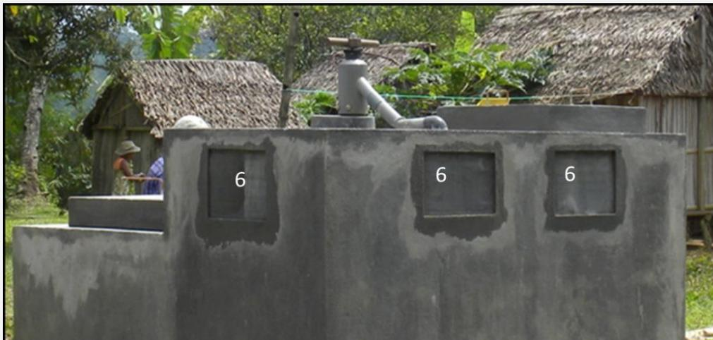
**Photo 3 : Fenêtres d'aération avec grillage**
