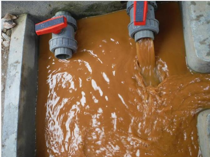
**Photo 11 : Ouverture de la vidange de la chambre de décantation**
