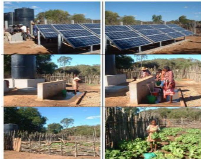
**Figure 8.** Pompage solaire exploitant le sous-écoulement de la Bemamba
