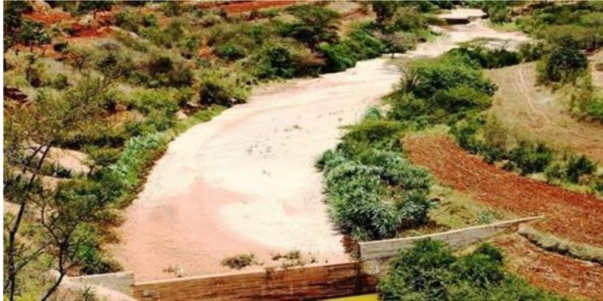
Figure 3. Photo d'un barrage souterrain captant un sous-écoulement de rivière sèche (Sakasaka) (Source : Energis fd)
