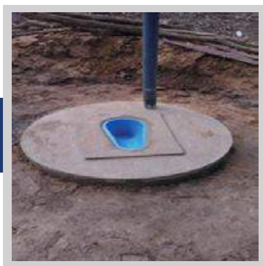
Vue de la latrine ventilée (LV)
