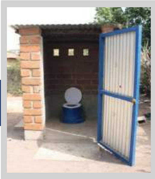
Vue de la Toilette à Chasse Manuelle (TCM)
