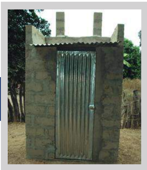
Vue de la latrine VIP
