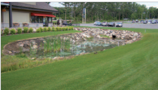
Figure 45 : Bassin dans un secteur commercial et institutionnel.
