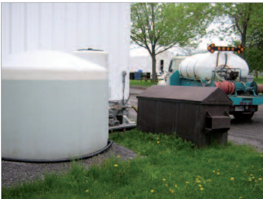
Figure 16-B : Récupération par camion-citerne.
