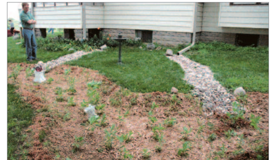
Figure 48 : Gouttières raccordées à un jardin de pluie.
