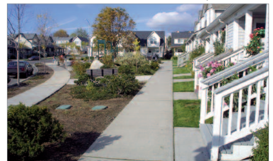
Figure 49 : Gouttières raccordées à une plate-bande.
