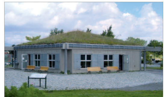
Figure 29 : Toiture du pavillon de service du Domaine Maizerets, Québec.
