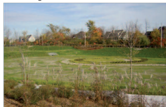
Figure 14-F : Bassin de rétention du Boisé.
