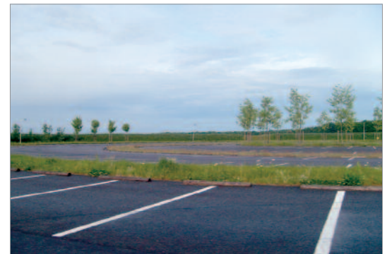
Figure 23 : Jardin de pluie dans une aire de stationnement.
