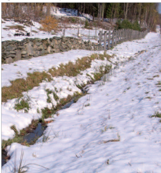
Figure 8-C : Fossé pouvant servir à la rétention.
