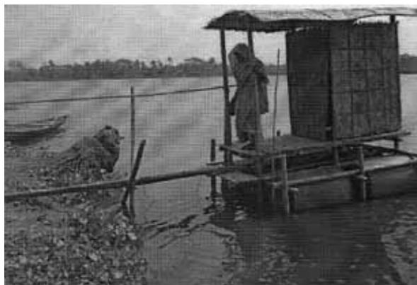
Un latrine flottante peut être utilisée là où il n'y a pas d'espace sur la terre ferme pour construire des toilettes
