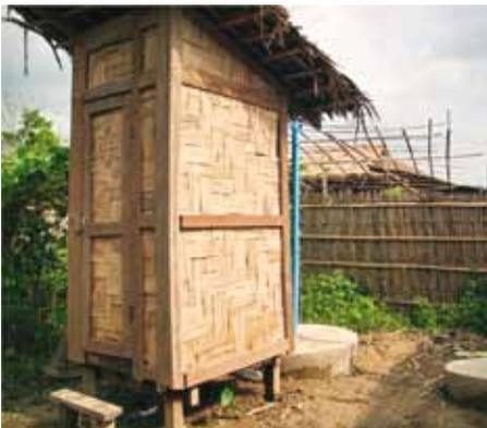
Latrine à double fosse dans l'Etat de Rakhine du nord au Myanmar. Lorsqu'une des fosses est pleine, le contenu est recouvert de terre pour que le compostage s'effectue (pendant 18 mois) et la superstructure est déplacée afin d'être raccordée à la seconde fosse. Cette idée de « superstructure mobile » provient des villageois eux-mêmes.
