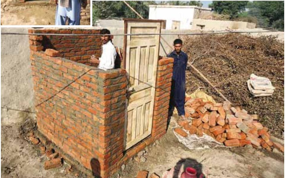
L'intérieur de la cabine des toilettes doit rester suffisamment sombre afin d'éloigner les mouches, mais il est important de prévoir une ouverture, la plupart du temps située au-dessus de la porte, pour permettre à l'air d'entrer à l'intérieur. La ventilation peut être renforcée en orientant la cabine de façon à ce que la porte soit située face au sens des vents dominants. Chaque trou pour la défécation doit avoir sa propre fosse et chaque fosse doit être ventilée individuellement.
