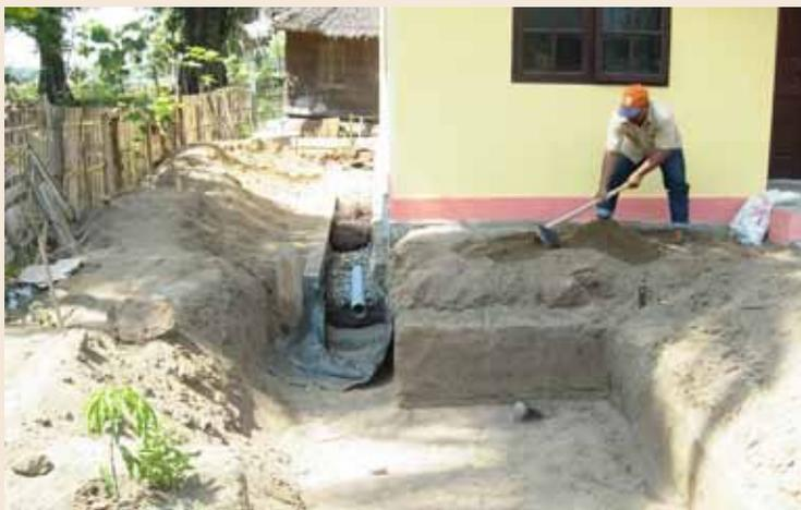
Indonésie : construction d'un filtre planté et d'un lit d'infiltration dans lequel les effluents prétraités dans le réservoir Biofil continuent le processus de traitement avant d'être finalement infiltrés dans le sol.
