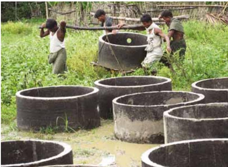
Fabrication d'anneaux de béton à Buthidaug au Myanmar
