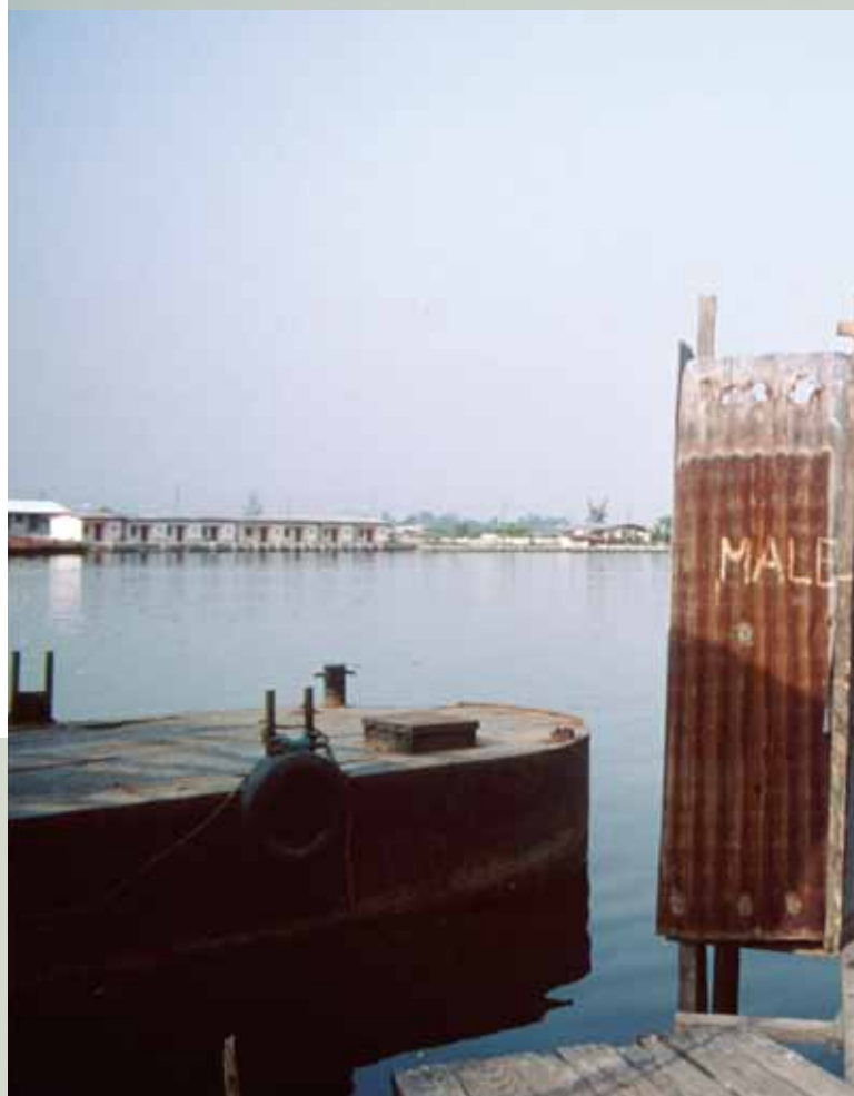
Sanitaires précaires, Port-Harcourt (Nigeria) - © IRD/Pérouse de Monclos
