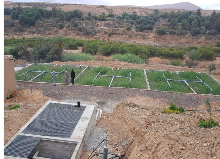
L'entretien se limite à une inspection bihebdomadaire pour nettoyer le dégrillage, vérifier le fonctionnement du siphon et pratiquer l'alternance d'alimentation des filtres et des vannes de vidange, un faucardage annuel des roseaux et l'enlèvement, non pas de boues mais d'un terreau, tous les 10 ans.
