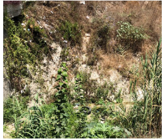
Enfouissement déchets solides
