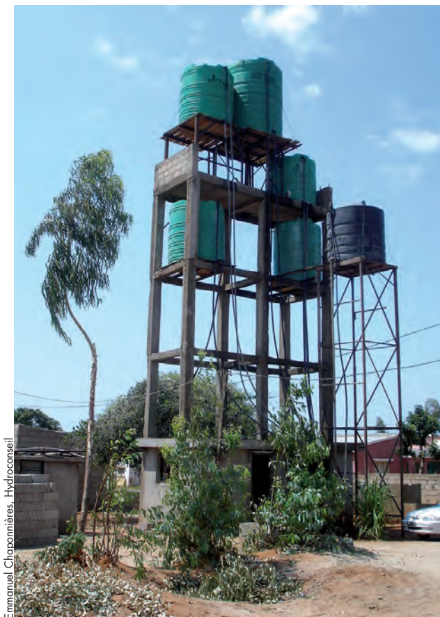
Château d'eau constitué de modules d'une capacité de 2 à 10 m 3 chacun.
