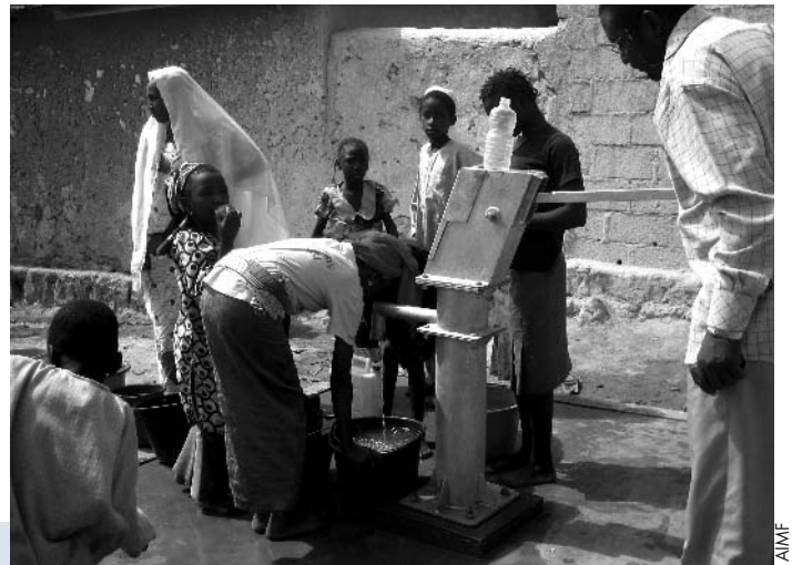
Les 10 forages réalisés, d'une profondeur de 47 et 60 m et d'un débit de 0,7 à 1 m 3 /heure, ont été équipés de pompes manuelles INDIA et de protections anti-bourbier.
