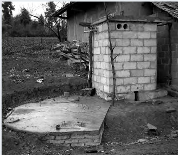
Les latrines sont placées au-dessus du réservoir de biogaz et directement reliées au digesteur.
