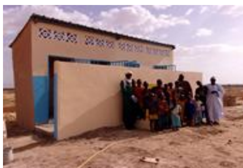
Bloc sanitaire et borne fontaine
