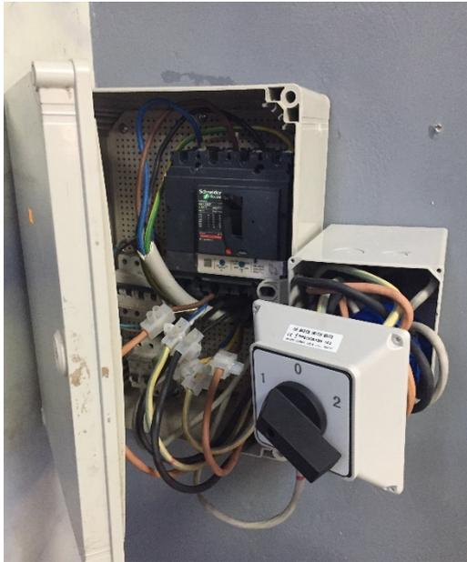
Figure 8. L'inverseur manuel sur le chantier d'installation de l'entreprise Fouta Poids Lourds (Auteur, juillet 2022)
