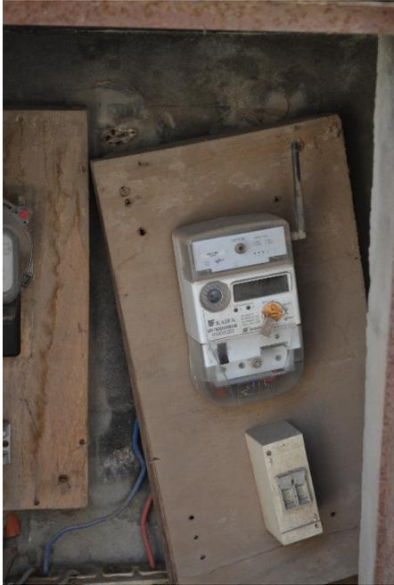
Figure 10. Compteur bidirectionnel intelligent installé sur la maison bioclimatique (Auteur, juin 2022)
