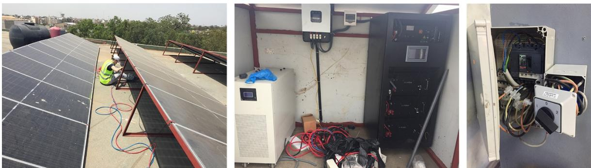
Figure 4 : Chantier d'installation du système solaire PV pour l'entreprise Fouta Poids Lourds, Mbao, Pikine (Auteur, juillet 2022). Installation des panneaux solaires PV - raccordement à l'onduleur, régulateur et batteries - inverseur manuel (de gauche à droite).
