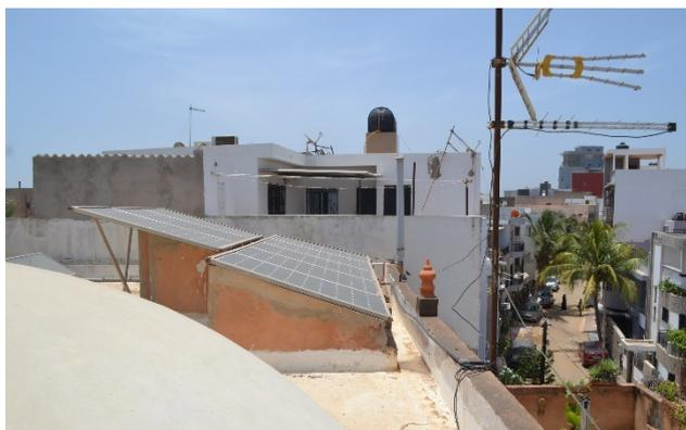
Figure 6 : L'installation solaire sur le toit de la maison bioclimatique, Liberté 6, Dakar , (Auteur, juin 2022)
