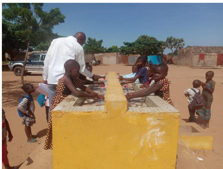
Figure 11: Exemple de DLM groupé et connecté au réseau réalisé par KYNAROU dans des écoles de Bobo-Dioulasso
