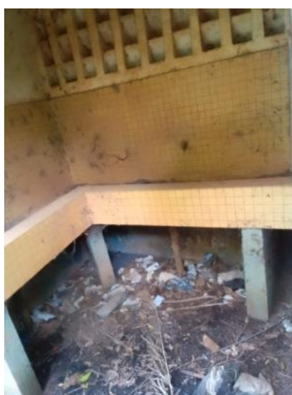
Figure 7 : Dispositif de lavage des mains inutilisé dans une école
