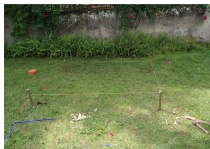
Veillez à ce que les piquets soient à angle droit l'un par rapport à l'autre en attachant une corde autour des piquets et en comparant l'angle que fait la corde à un piquet avec l'angle de 90° d'une équerre de construction.
