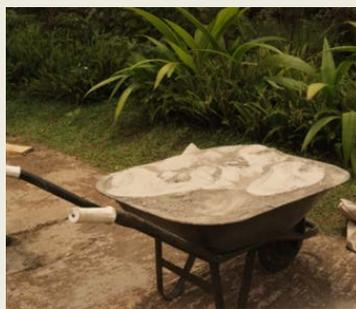
Nettoyez la surface où le béton sera fait. Utilisez un mélange de 1 brouette de ciment, 2 brouettes de sable et 3 brouettes de gravier. Avant de charger la brouette avec le sable, tamisez-le. La surface du sable, ciment ou gravier dans la brouette doit être plate et à niveau avec le haut de la brouette.
