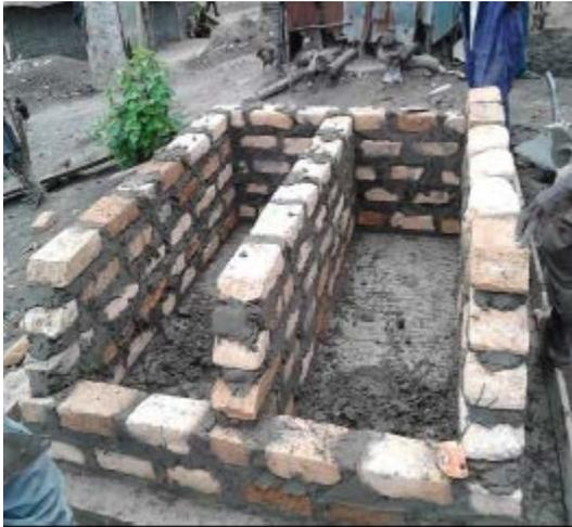
Tous les murs des compartiments ont une hauteur de 90 cm sauf le mur en arrière qui a une hauteur de 30 cm. Ce mur servira de base pour les couvercles des compartiments de stockage. Les murs latéraux des compartiments seront construits avec une pente pour permettre aux couvercles de reposer à angle incliné à l'arrière de la toilette.
