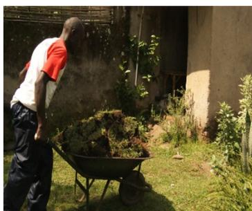
Chargez le sol excavé sur une brouette et déposez-le dans un endroit approprié en dehors du site.
