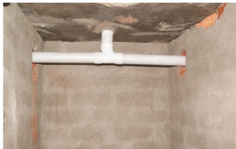
Dans le cas de nettoyage anal à l'eau, faites la même chose pour le tuyaux d'évacuation de l'eau du nettoyage anal. Faites un trou dans le mur entre les deux compartiments et insérez un tuyau de 50 mm avec un coude. Raccordez un tuyau au coude. Faites un trou dans le mur extérieur. Passez un tuyau de 50 mm par ce trou et accordez au coude. Veillez à ce que le tuyau ait une pente de 2 cm. Bouchez les ouvertures autour des tuyaux dans les murs avec du mortier.
