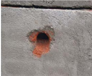
Coupez à l'aide d'un burin un trou dans une paroi extérieure d'un compartiment et un trou dans le mur entre les deux compartiments, à l'endroit où le tuyau d'évacuation d'urine va passer.
