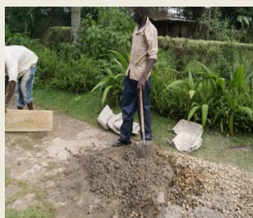
Étalez le mélange sable-ciment sur la surface et étalez sur celui-ci 4 brouettes de gravier. Ajoutez de l'eau mais pas trop et malaxez. Un béton qui contient trop d'eau est deux fois plus fragile qu'un béton bien dosé. Veillez toujours à ce que le mélange de béton soit utilisé dans les 30 minutes à partir du moment où l'eau est ajoutée.
