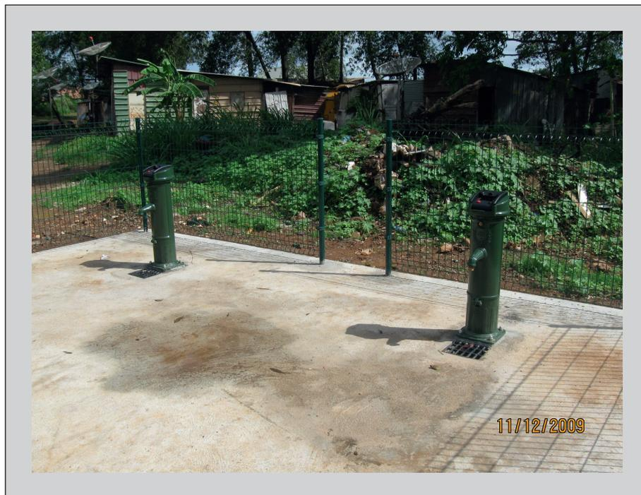
**Figure 2.** Bornes fontaines à cartes prépayées installées à Cayenne.
