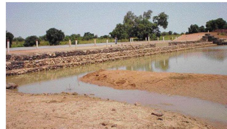
Fig. 4.2.6 Sotie d'évacuation du barrage de Mago vue de l'aval
