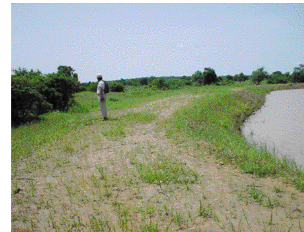
Fig. 4.3.5 Aménagement de mare par surcreusement du fond et construction de digue
