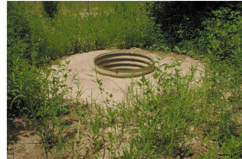
Fig. 4.4.3 Puits semi-traditionnel utilisant des buses métalliques (diamètre: 1 m)
