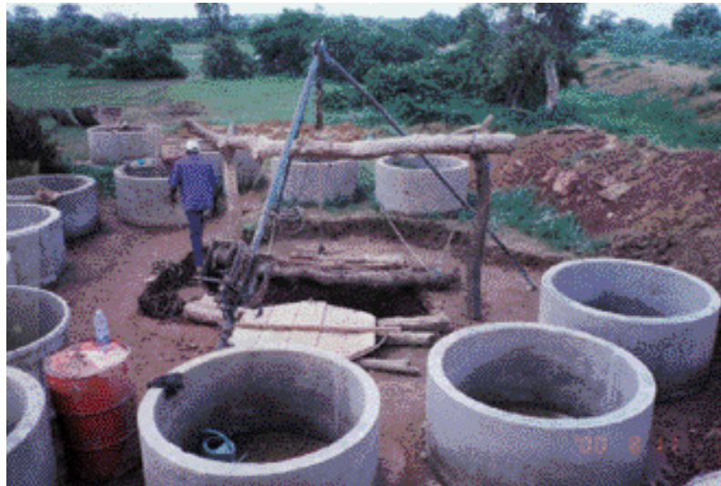
Fig. 4.4.2 Etat de la mise en place Puits modernes à grand diamètre
