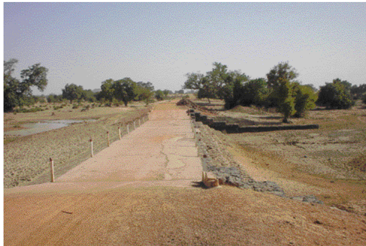
Fig.4.2.1 Evacuation d'eau du barrage de Mago pendant la saison sèche
