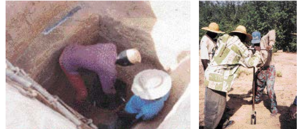
Fig. 3.4.10 Exemple de creusement par sonde à cuiller
