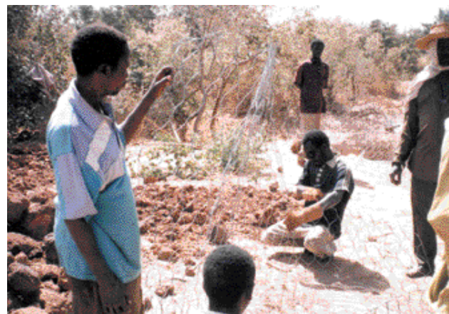
④ Assemblage du gabion
