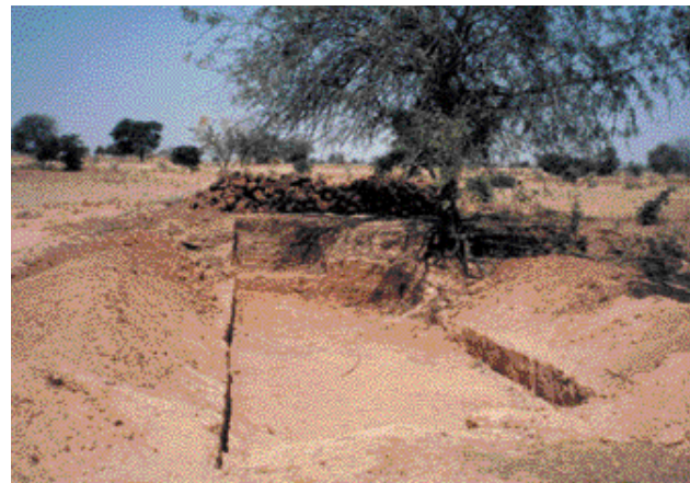
② Creusage des fondations terminé
