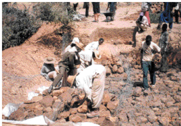
⑤ Travaux de dépôt des pierres
