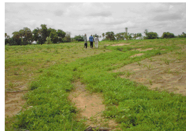
Ravin en cours de réparation par l'ensablement
