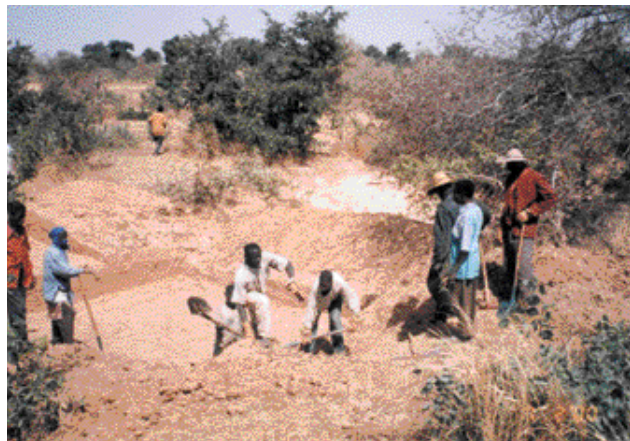
① Creusage des fondations
