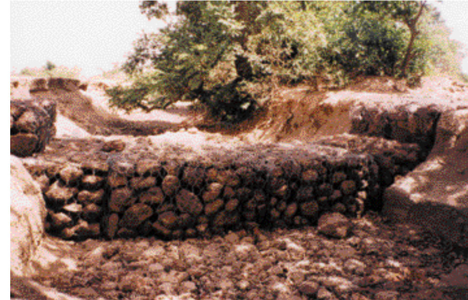
Fig. 3.2.(15) Exemple de réparation de grande envergure à l'aide d'un gabion
