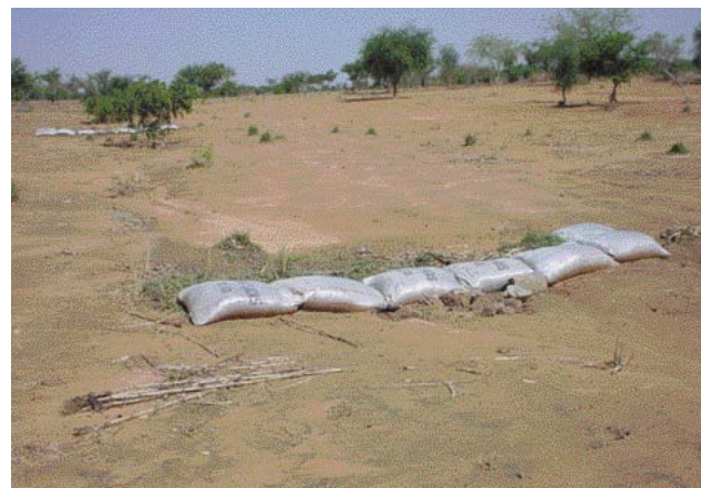
Mise en place d'une ligne de sacs de terre
