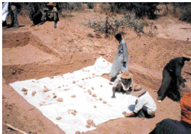
③ Une toile de protection contre l'affouillement est étendue
