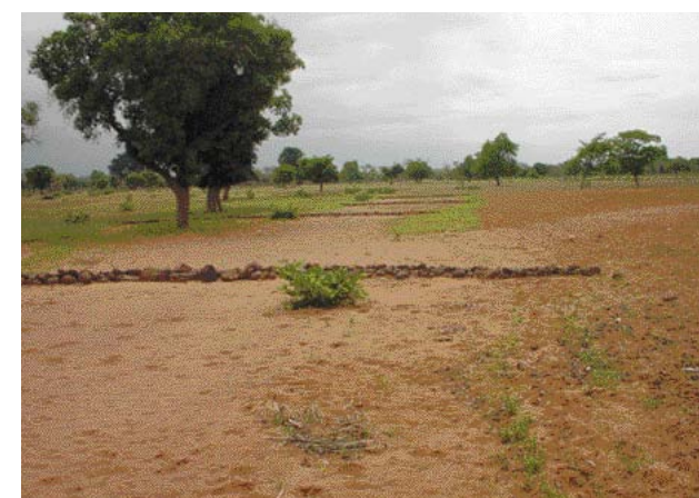
Ligne de diguettes en pierres installée dans une rigole
