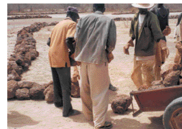
Travaux d'installation des diguettes en pierres
