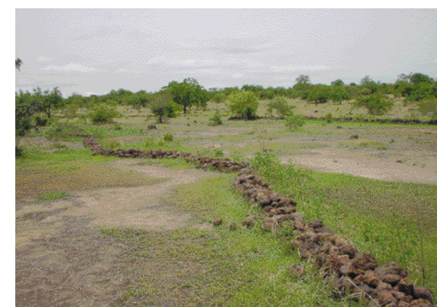
La mise en place des diguettes en pierres
