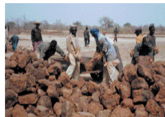
Transport et empilement des pierres rassemblées
