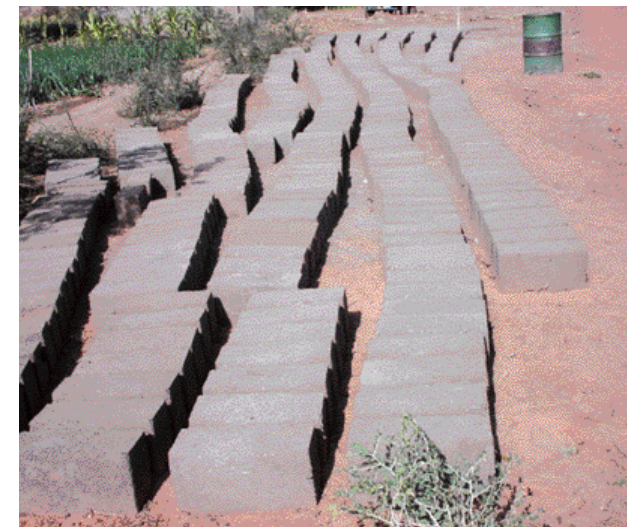
Fabrication des parpaings
