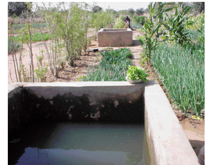
Réservoir en parpaings achevé
