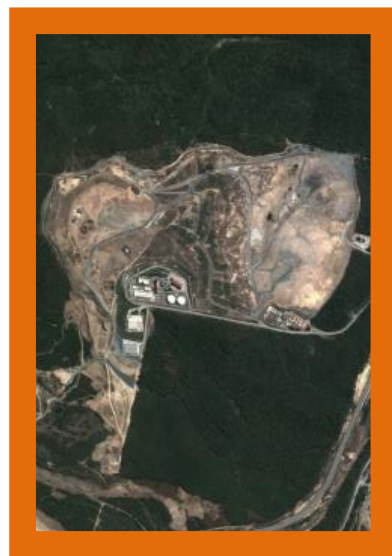
Vue aérienne du site d'enfouissement d'Odaveri (rive européenne)
