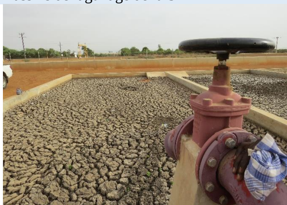
Lits de séchage plantés
