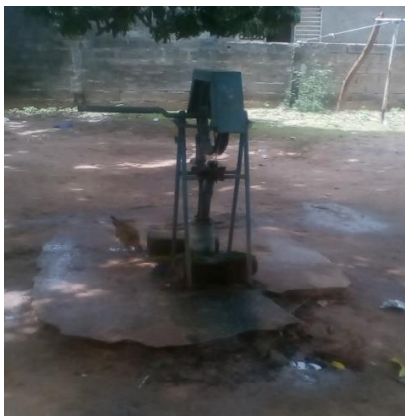
Puits muni d'une pomme manuelle
