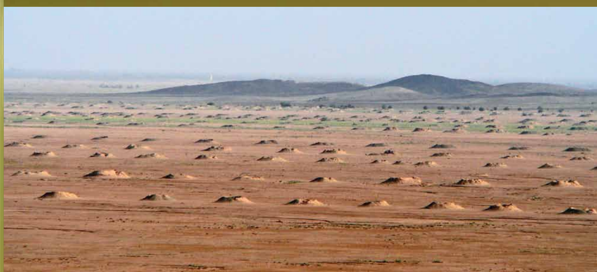
Les puits des khettaras du Tafilalet s'alignent sur des dizaines de kilomètres entre les oasis et les sources.
