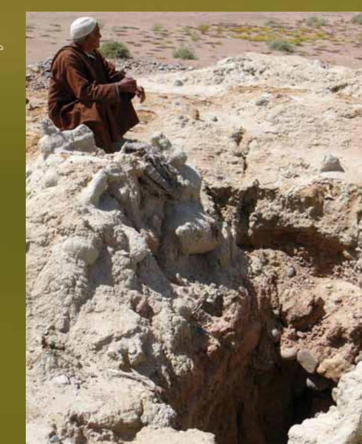
Les puits mesurent jusqu'à 20 mètres de profondeur et la largeur d'un homme. Ils servent à creuser, aérer et entretenir les galeries.
