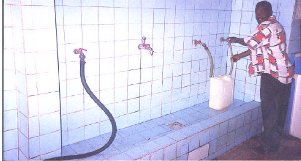
Photo. 17 : Installations de revente d'eau déminéralisée
