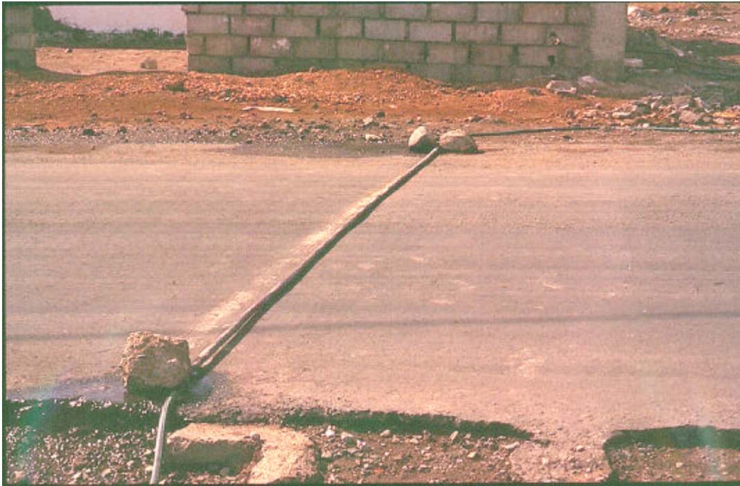
Photo. 11 : Tuyau dans une conduite en acier posée sur une route goudronnée. Les pierres sur les deux extrémités servent d'appui pour faciliter la circulation
