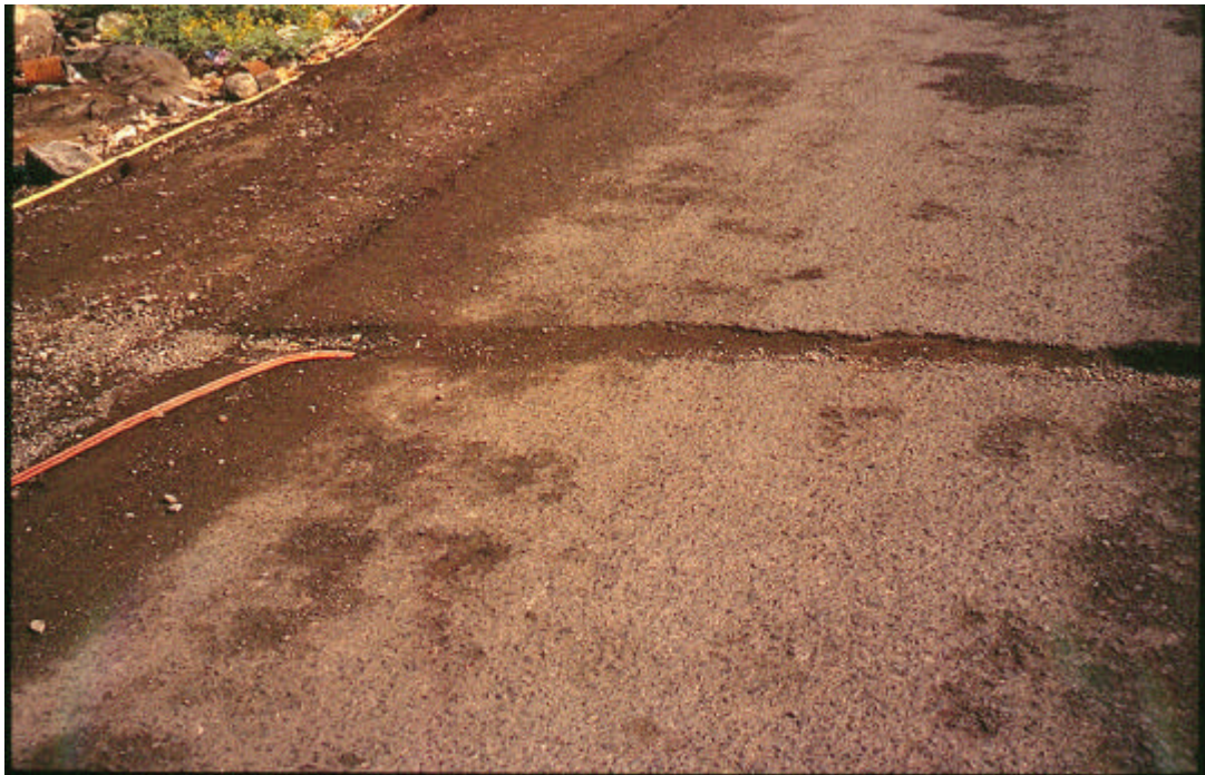
Photo. 12 : Tuyau enfoui sous une route goudronnée dans les quartiers de Balbala
