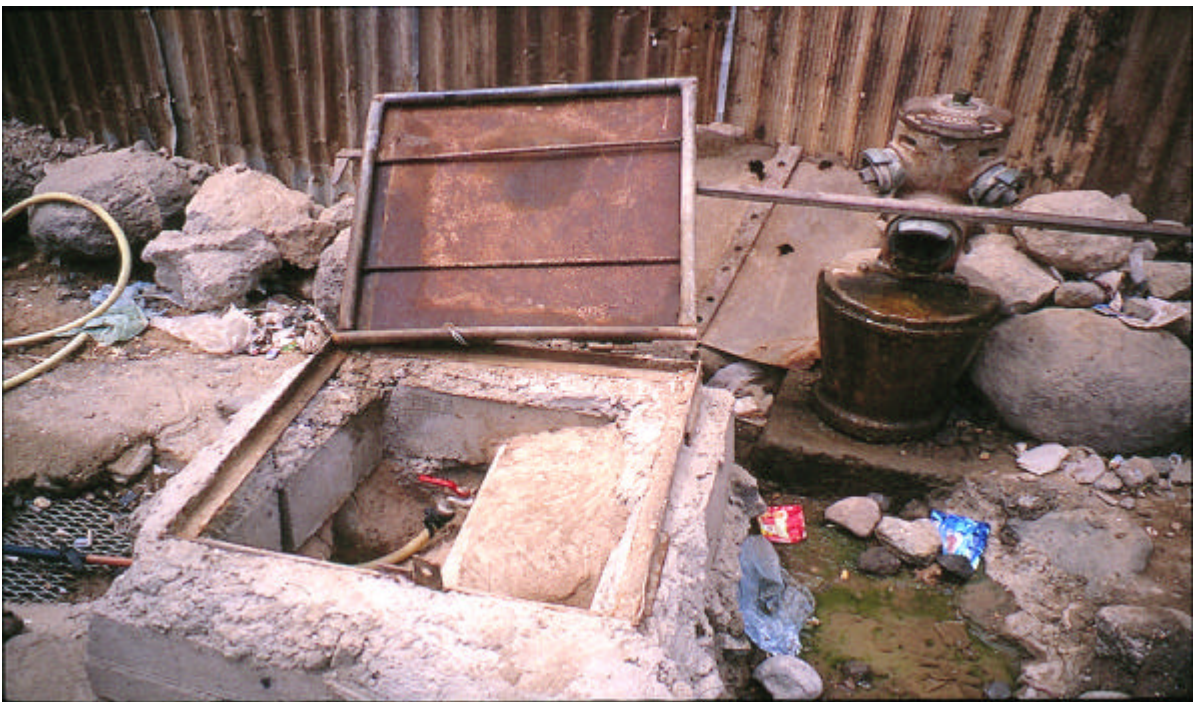
Photo. 10 : Dérivation de la conduite d'arrivée : 2 ème phase du processus avant la disparition complète de la bouche d'incendie
