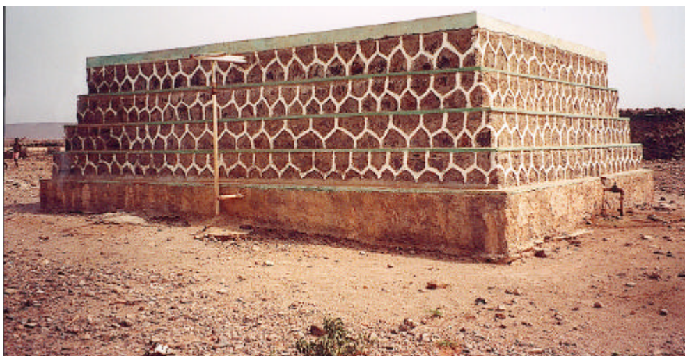
Photo. 3 : Réservoir d'eau relié à un forage
