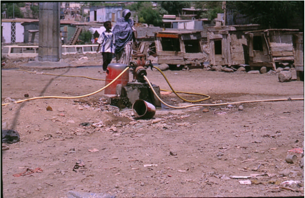
Photo. 9 : Alimentation à partir d'une bouche d'incendie : 1 ère phase du processus de transformation en fontaine
