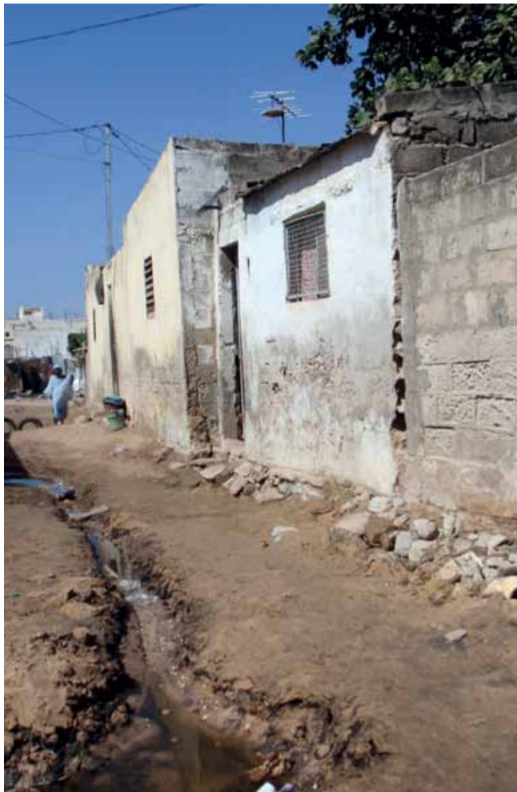
Agglomération de Dakar. Evacuation des eaux usées à ciel ouvert au milieu de la rue.
