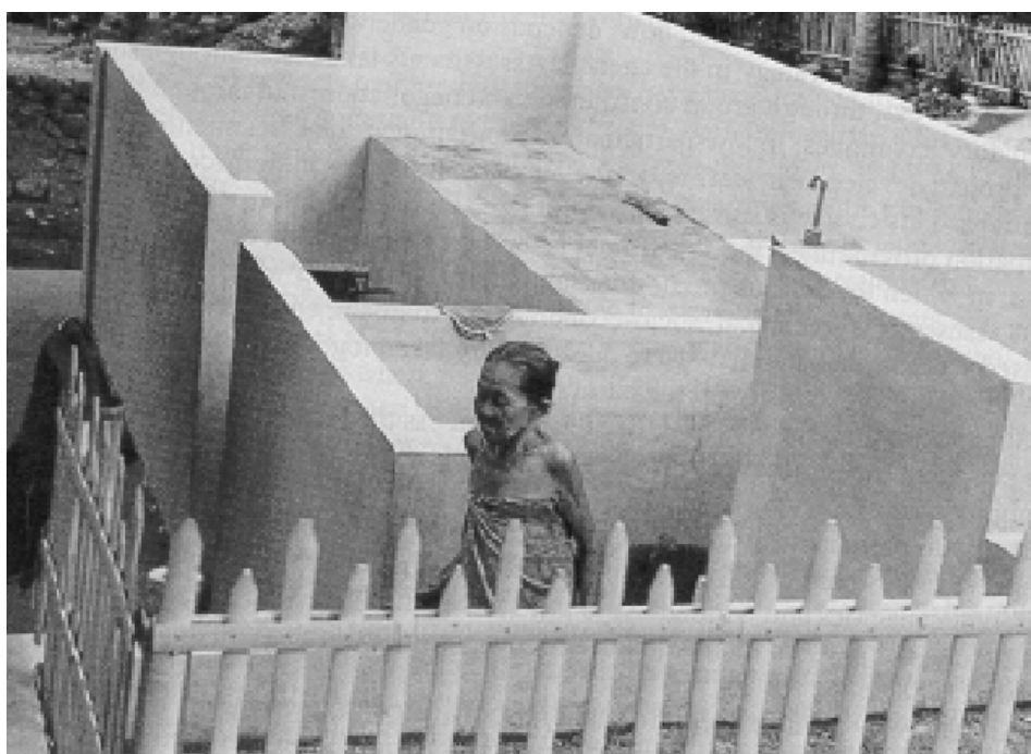
Schéma 8. Equipement amélioré de lessive et de lavage conçu et géré par les consommateurs dans un kampung Indonésien (photo: Sumintardja, institut d'établissement humain)
