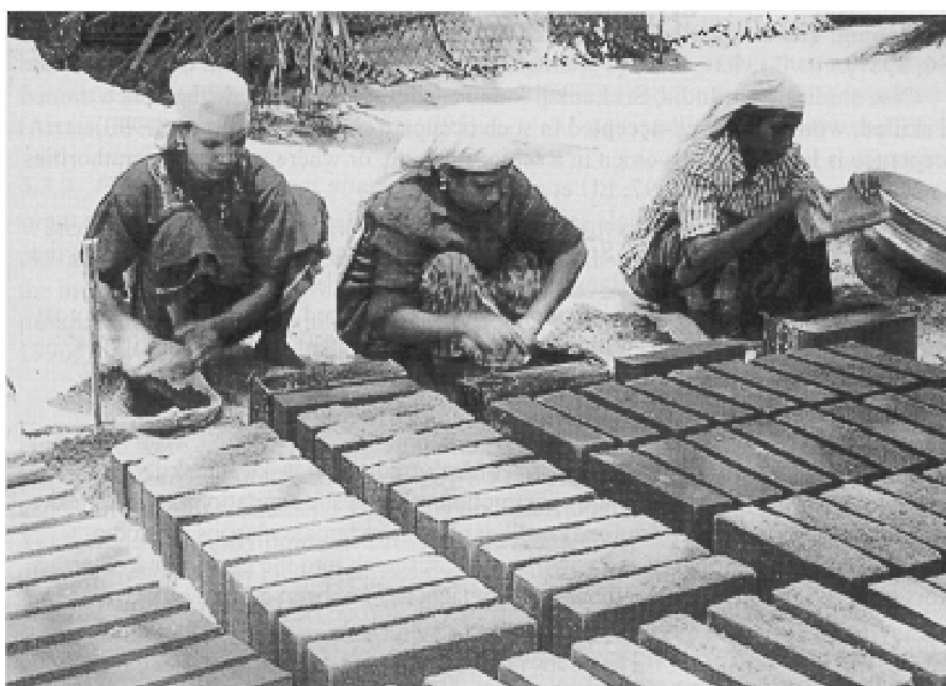
Schéma 18. Confection de blocs par des maçonnes (photo: SEUF, Kerala en Inde)
