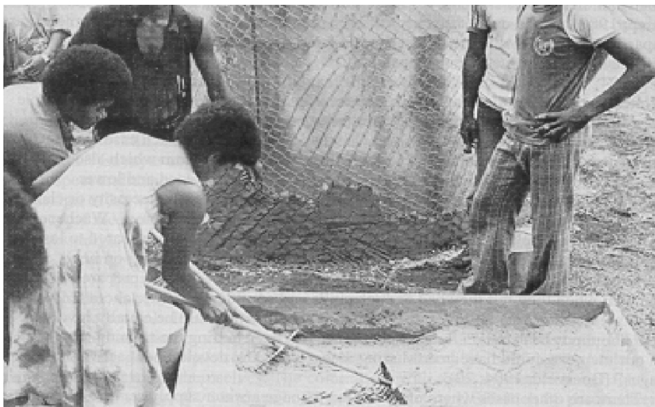
Schéma 12. Les projets de collecte des eaux pluviales, tels qu'ici à Tonga, tendaient à être ceux des femmes plutôt que des projets communs, avec groupes de femmes assurant toute la construction et le financement (Photo IRC par Akil Khan)
