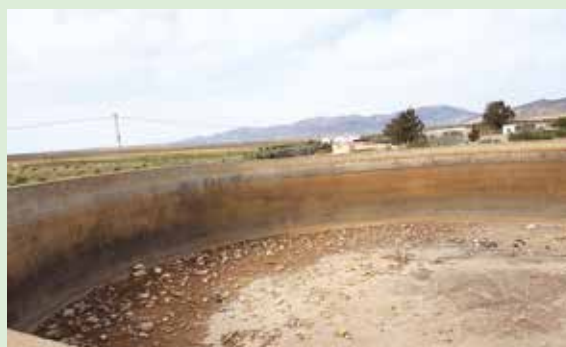
Bassin d'eau non utilisé
