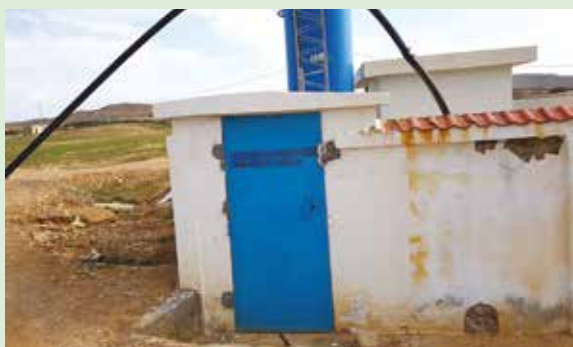
Forage du périmètre public irrigué à Khanguet Ezzezia
