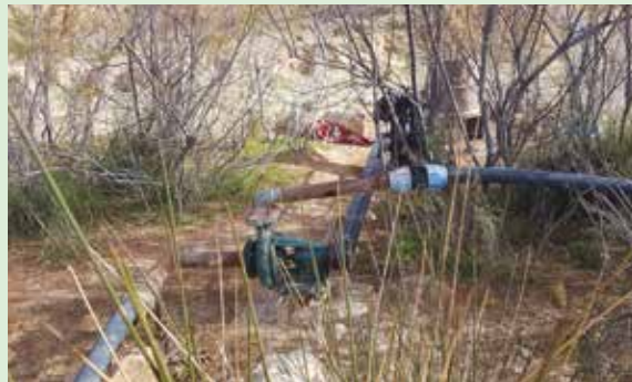
Pompage depuis le bassin de stockage
