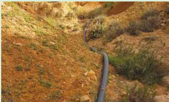
Conduite de refoulement
