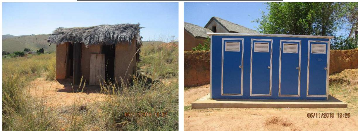
Sur l'assainissement individuel, les latrines sont souvent construites en murs de briques avec des portes en bois. Les dalles sont soit en bois ou en béton. La vidange des fosses et l'utilisation de fosse septique sont encore inexistantes. Dans les autres localités, des poteaux en bois sur lesquels sont fixés des sacs en plastics, avec un trou creusé au centre, font office de latrines. Le tableau suivant donne la situation de l'accès à l'assainissement en Novembre 2019.
