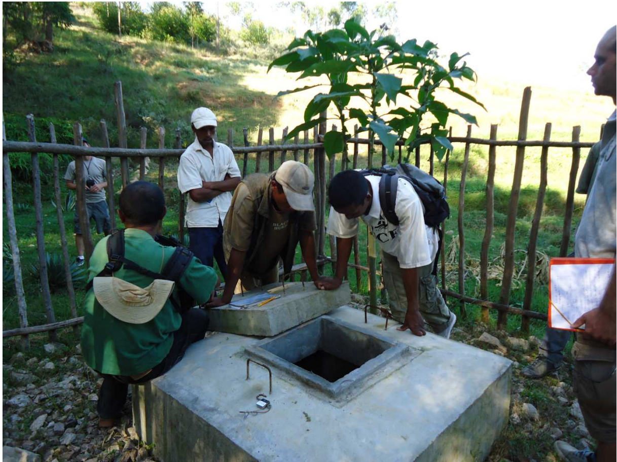
Photo 7 : boîte de captage d'Antamponala
