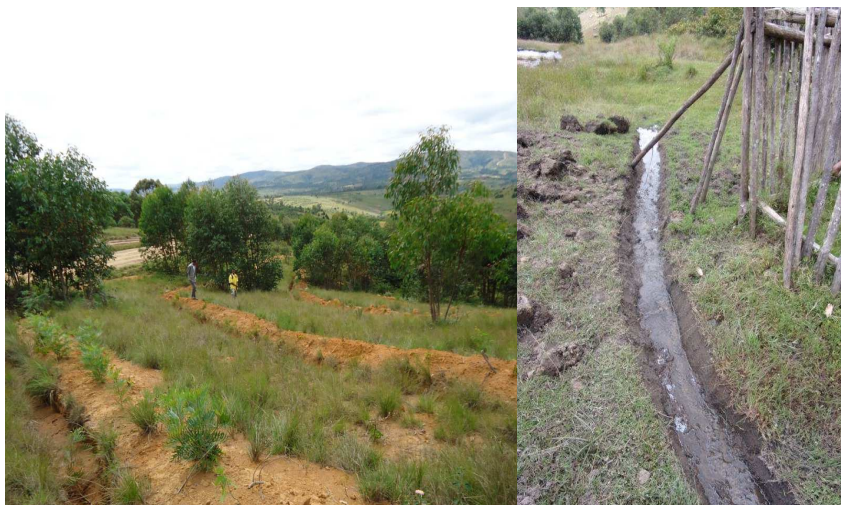
Photos 10 et 11 Protection du captage et drainage du périmètre à poursuivre
