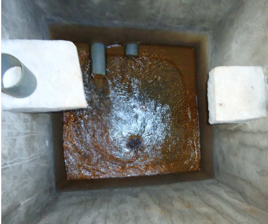
Photo 5 Captage d'Antamponala, sortie des drains de captage en haut tuyaux gris. Débit important de l'ordre du 1 l/s. Trop plein très actif. Départ de la prise d'eau non visible. Dépôts ferriques importants. Ne semble pas avoir été nettoyé récemment (4 visites et nettoyages annuels prévus) Périmètre de protection rapproché est existant et solide. Un élargissement du périmètre de protection est en cours à partir de la plantation d'épineux.
