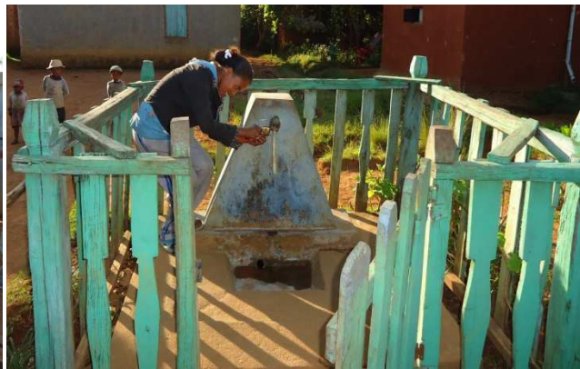
Photo 14 : Borne-fontaine réalisée en 2013 branchement particulier avec compteur à Ambodivonkely
