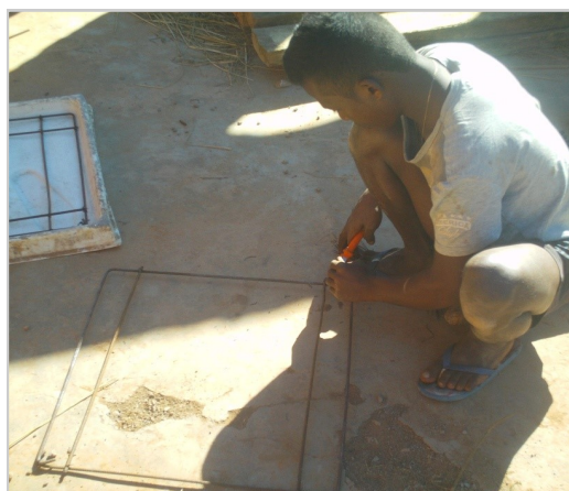
Dalle San Plat en cours de fabrication
