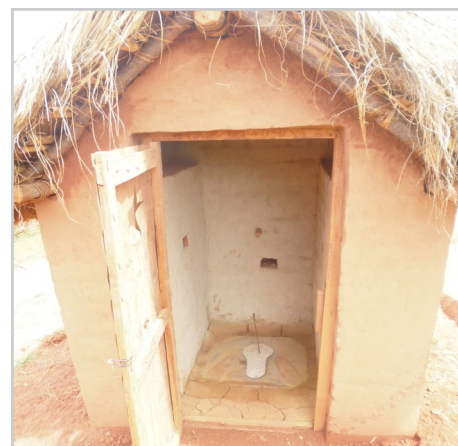
Latrine équipée d'une dalle San Plat
