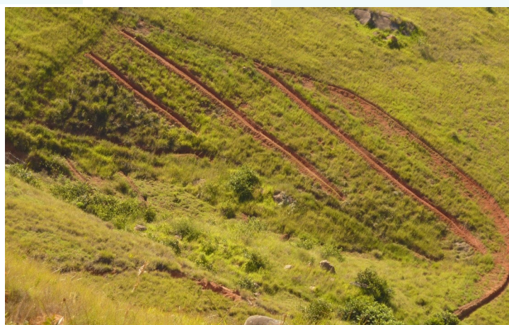
Bassin versant aménagé: plantation de Vétiver, Acacia et Frêne, bande enherbée et fossé d'évacuation du ruissellement.
