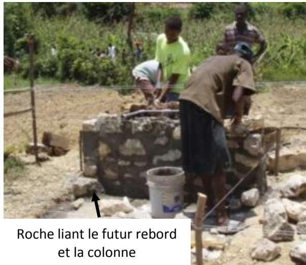
Photo 42: Construction de la colonne en roches maçonnées
