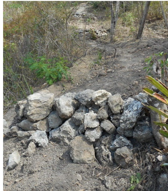
Photo 73 : Mur en roche sèche perpendiculaire à l'adduction
