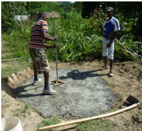
Compaction du béton maigre
