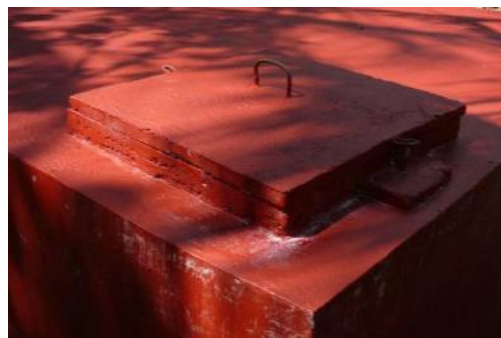
B) Porte en béton surélevée sur dalle en béton (système à deux cadenas)
