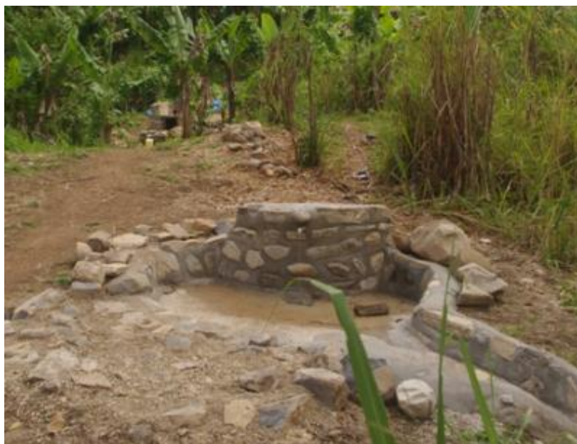
Byen-Plase Boîte de captage (en arrière-plan) et borne fontaine
