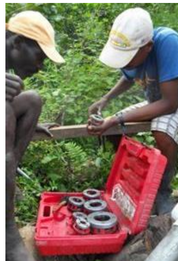
Photo 64: Fileter les tuyaux galvanisés
