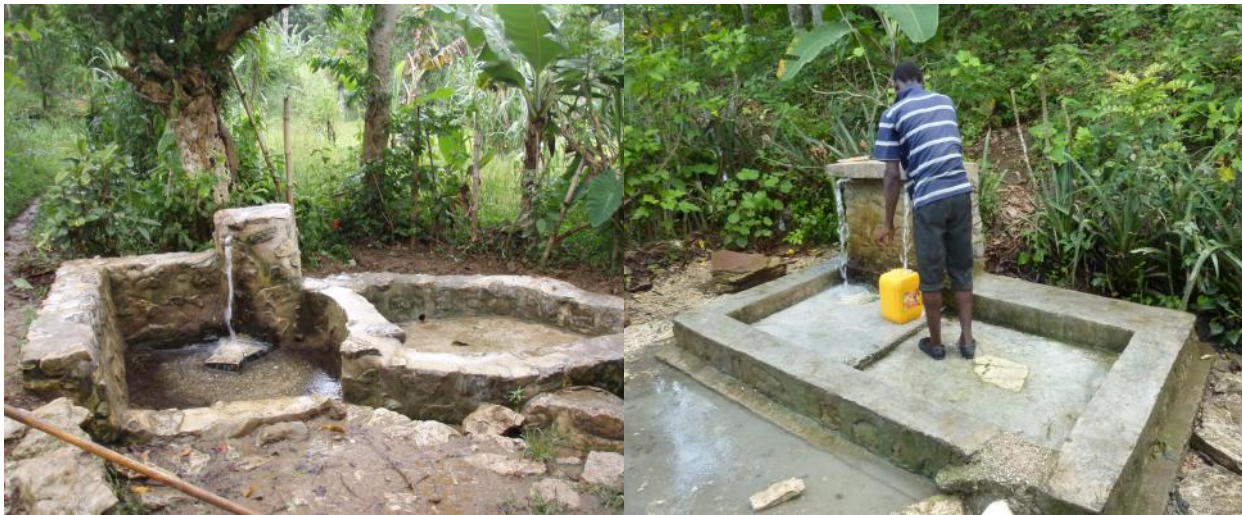
Aire de nettoyage détachée
