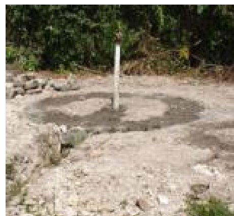
Photo 46: Fondation du réservoir avec tuyau du trop-plein / vidange
