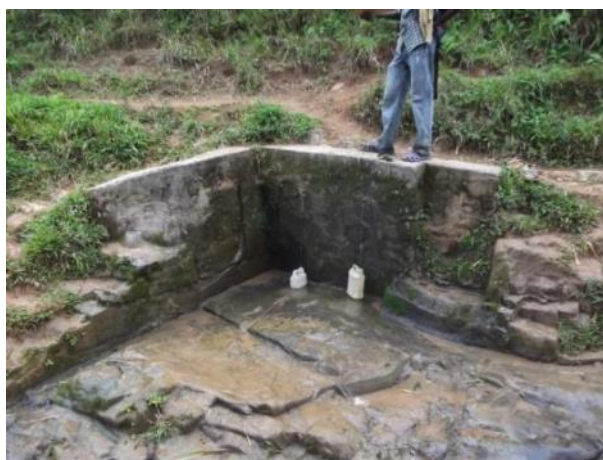
Photo 76 : Borne fontaine construite sur de la roche solide mais glissante
