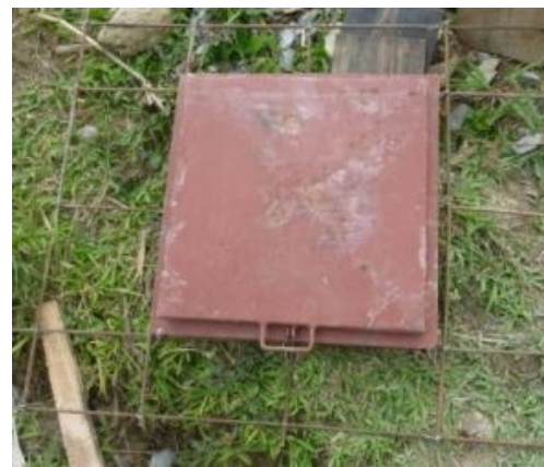
- Préparation du ferrailage
