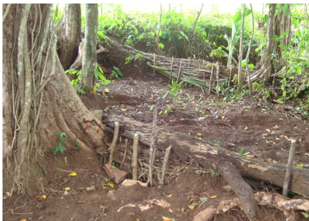
Seuil simple fait avec de la terre et des branchages morts (pente relativement faible)
