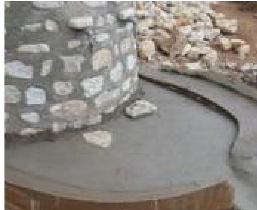
Photo 43 : Dalle de service avec roche de protection
