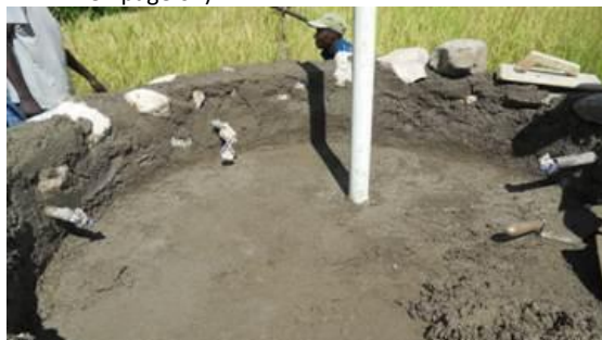
Photos 49 : Pose des tuyaux de sortie et de l'adduction en col de cygne
