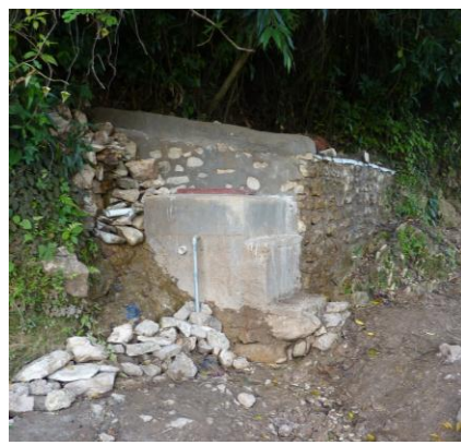
Photo 69 : Tuyau galva qui descend "chercher" le tuyau PE. Durable.
