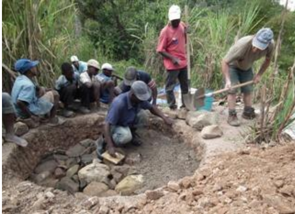
Fouille totale de la fondation
