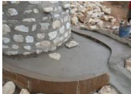
Photos 53: Dalle de service terminée
