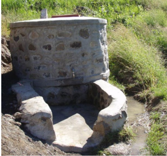
Photo 80: Canal à curer : Veiller à limiter l'eau stagnante !
