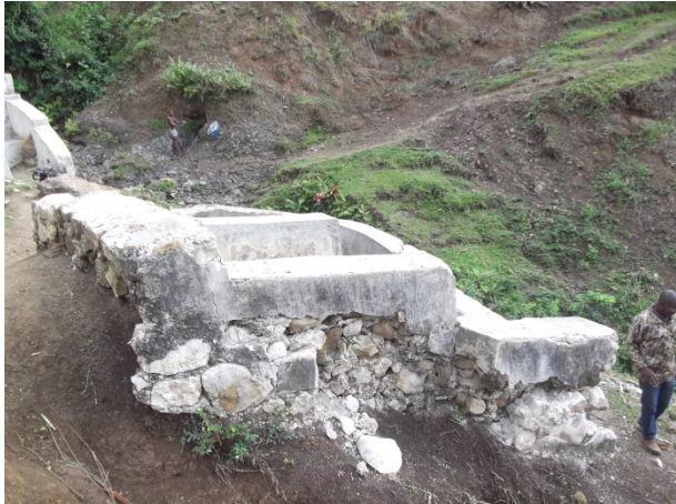
Point d'eau construit en 2005, sable de très mauvaise qualité et un faible dosage en ciment
