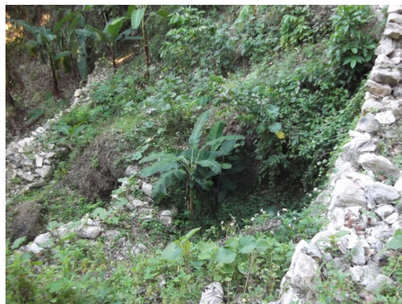
Seuil en pierre sèche dans une ravine en forte pente.
