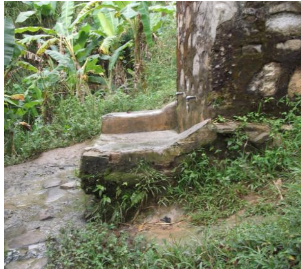
Photo 11 : Le terrain érodé à proximité de la citerne rend son accès moins aisé (en plus du réel risque de destruction)
