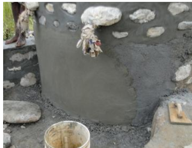
Photo 55 : Enduit sous les tuyaux de service
