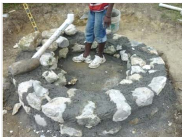
Photo 44: Construction du socle de la citerne, intégration du trop-plein / vidange avec coude 45°
