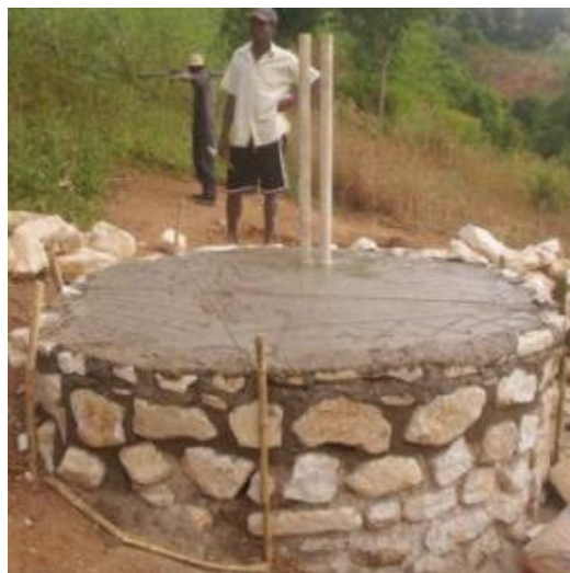
Photo 47 : Dalle de fond
