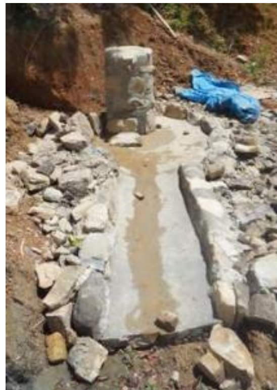
Photos 37 : Exemples de bornes fontaines
