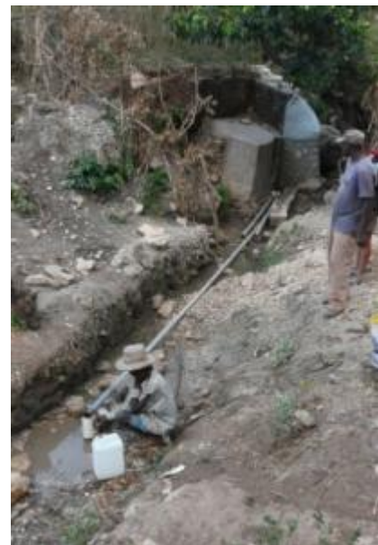
Photo 19 : Accès à l'eau pendant le chantier
