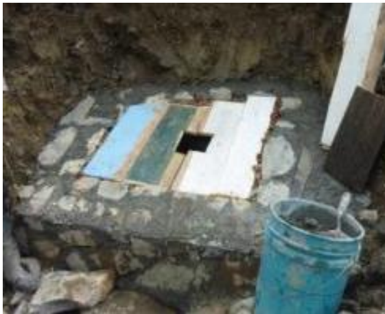
Photos 27 : coffrage de la dalle de couverture
