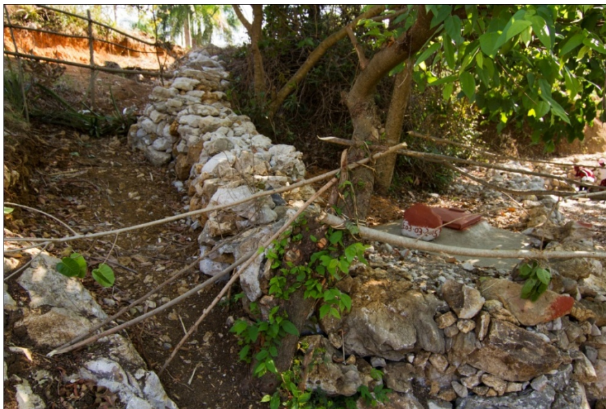
Photo 34 : Butte en roche sèche et canaux de déviation en amont de l'aire de captage
