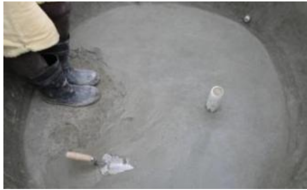
Photo 52: Dernière couche d'enduit
