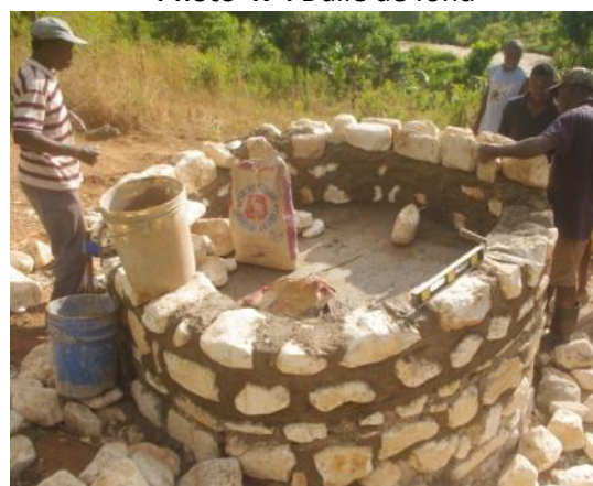
Photo 48 : Construction des parois
