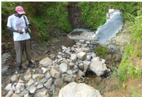
Roches maçonnées et roches sèches qui protègent l'adduction de la ravine
