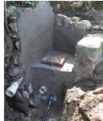
5 - Aménagement de la boîte
