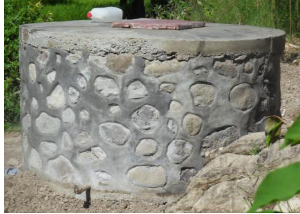
Photo 54 : Joint à l'haïtienne
