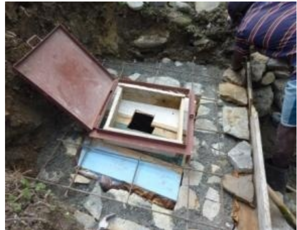
Photos 27 : coffrage de la dalle de couverture
