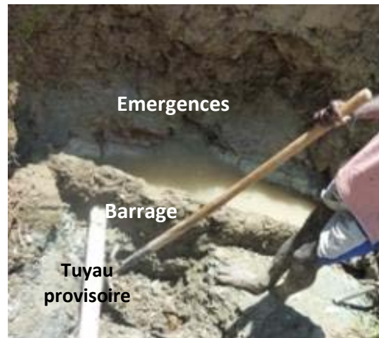
Photo20: Barrage Provisoire
