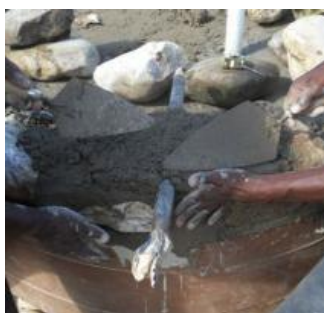
Photos 49 : Pose des tuyaux de sortie et de l'adduction en col de cygne
