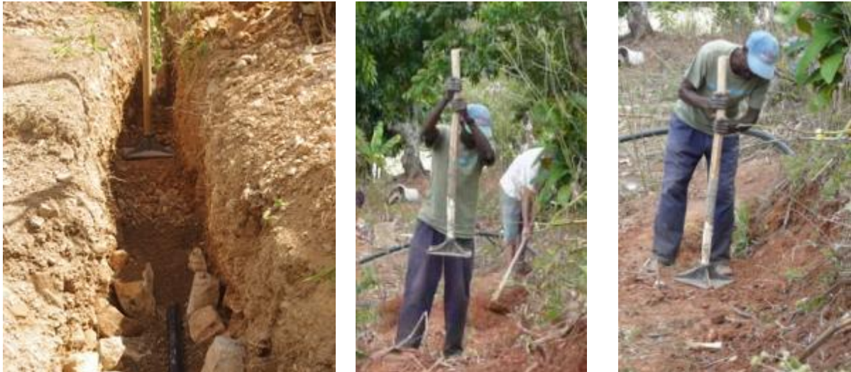
Photo 71: Recouvrement du tuyau par couches de terre damée
