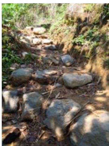
Escalier en pierres sèches
