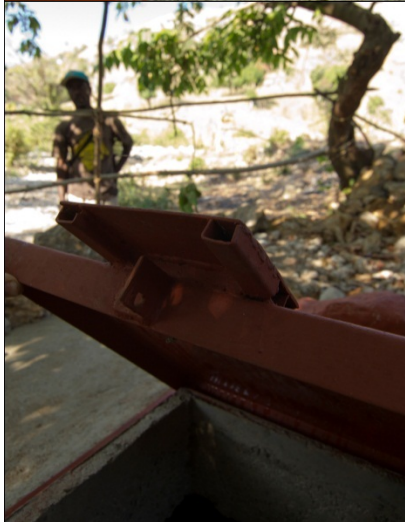
Photo 25: Détails de construction des portes en métal
