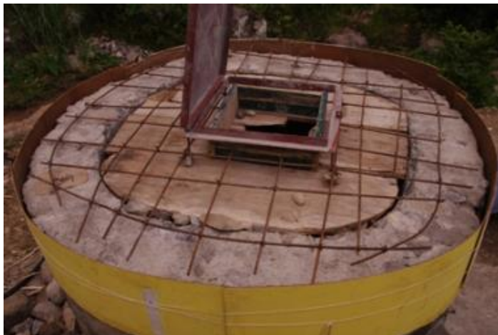
Photos 50: Coffrage de la dalle de toit
