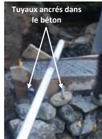
Photo 66: Ancrage des tuyaux
