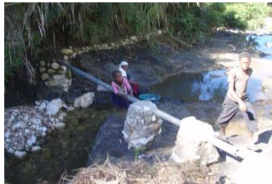
Fourreaux en acier galvanisé 3" qui protègent l'adduction de la ravine. Des plots plus solides auraient pu être utilisés : béton et forme ovale résistant à la poussée du cours d'eau
