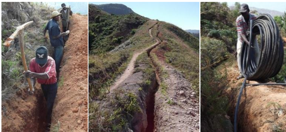
Photos 70: Fouille des tranchées et pose du tuyau
