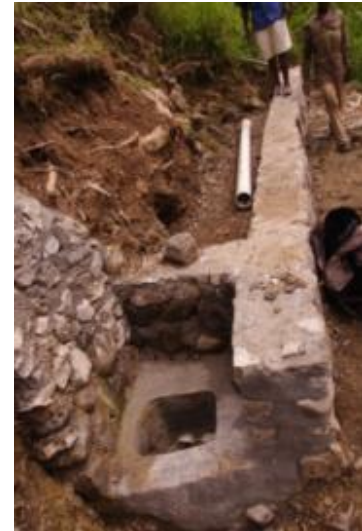
3 - Drain posé et couvert
