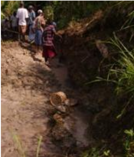
1 - Fouille du canal
