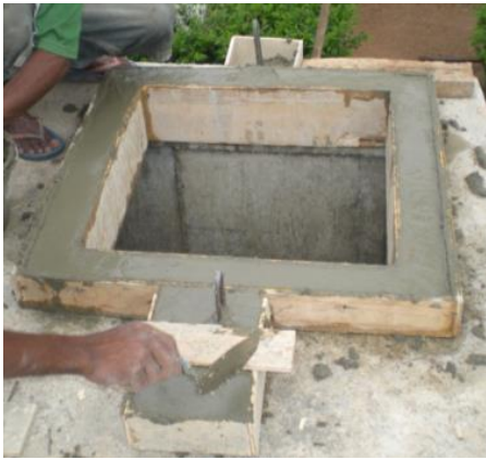
Support de la porte (il est préférable de le couler sur une dalle fraîche)
