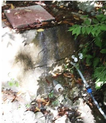
Photo 68 : Tuyau PE aérien qui "va chercher" le tuyau galva. Peu durable.
