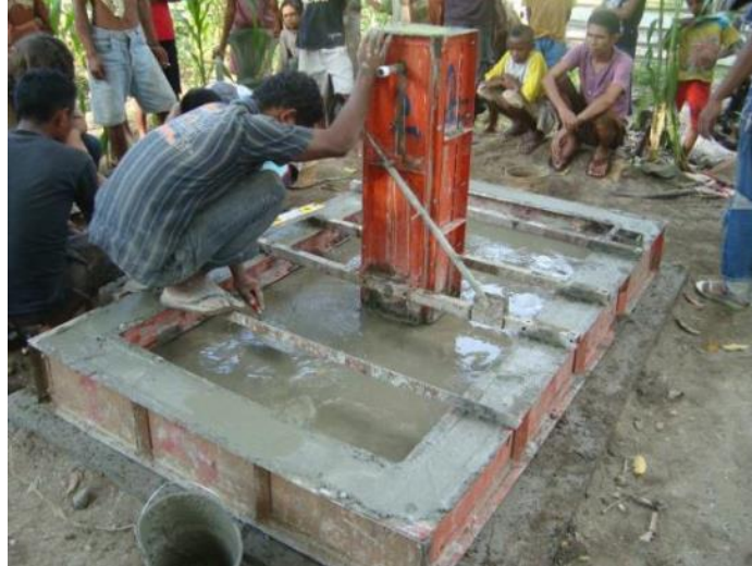
Photo 41: Coffrage métal permettant la coulée de la colonne et de la dalle en une fois
