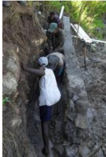
2 - Construction d'un mur barrage en aval du canal
