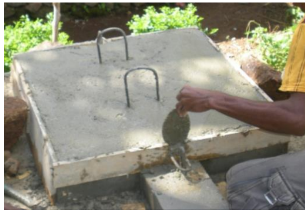
Porte coulée in situ
