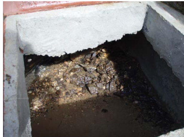
Photo 82: Nettoyage régulier indispensable pour éviter l'accumulation de racines et de solides dans la BC
