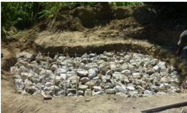
Hérisson et ferrailage
