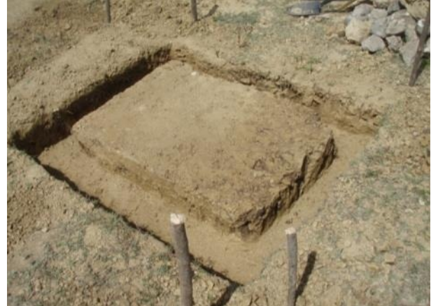
Fouille uniquement du pourtour de la fondation
