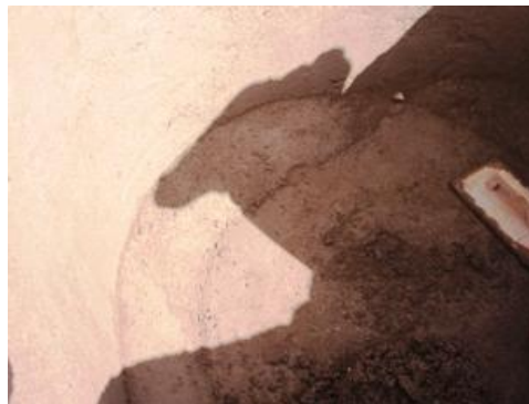
Photo 51: Jonction entre le mur et la dalle
