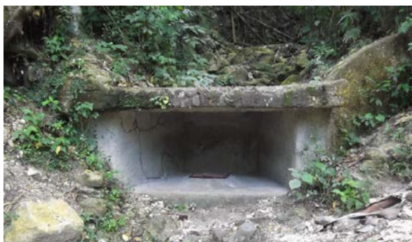
Photo 5: Protection de la porte d'un captage dans une ravine.
