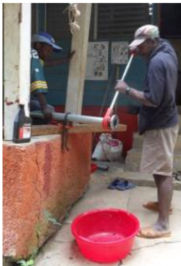
Photo 64: Fileter les tuyaux galvanisés
