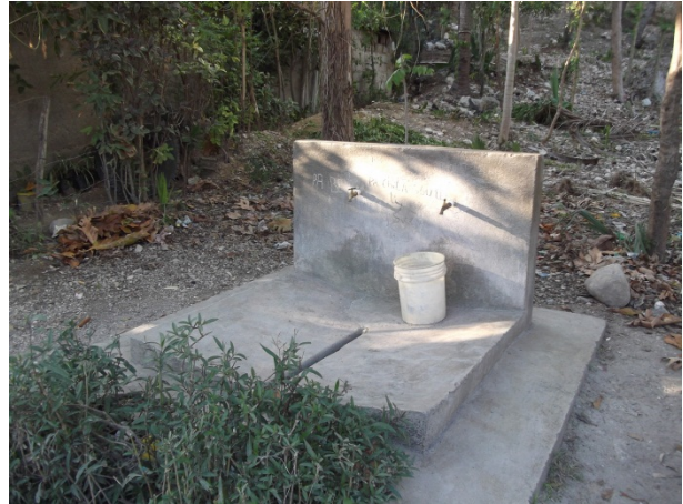
Point d'eau construit en 1995 avec des argégats de qualité et un dosage de ciment correct
