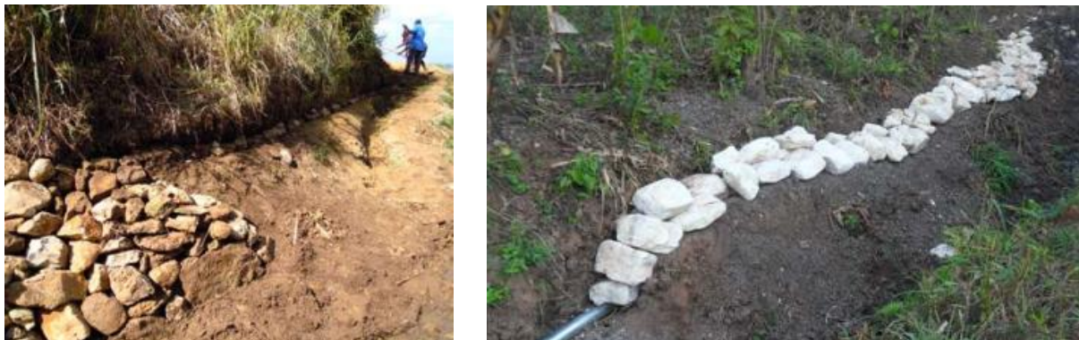
Photo 72: Recouvrement de l'adduction par des roches
