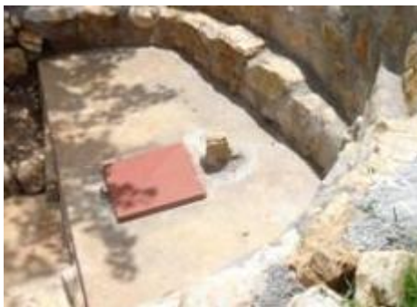
A) Porte en métal sur dalle en béton
