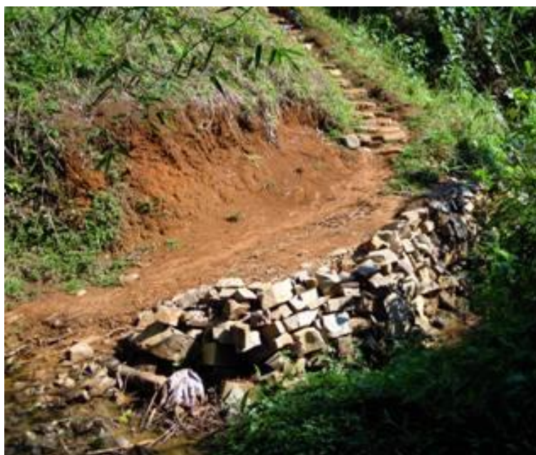
Mur de soutènement en pierres sèches
