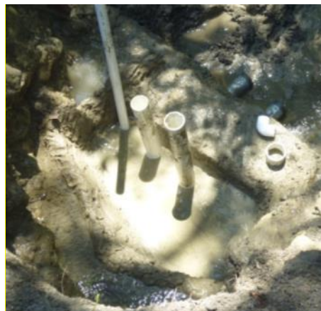
Photo 22: dalle coulée en une fois
