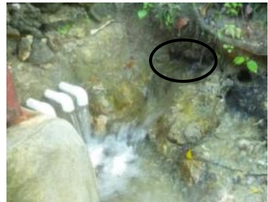
Fuite latérale importante passant autour du bras droit du barrage
