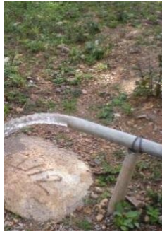
Photo 67 : Fixation des tuyaux en acier galvanisé
