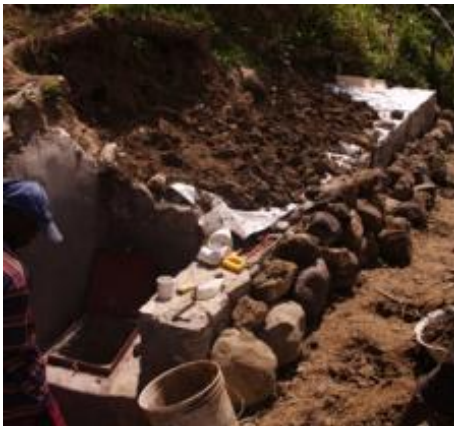
4 – Bâche pour protéger des eaux de ruissellement
