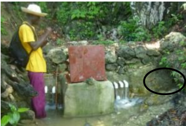
Fuite latérale importante passant autour du bras droit du barrage
