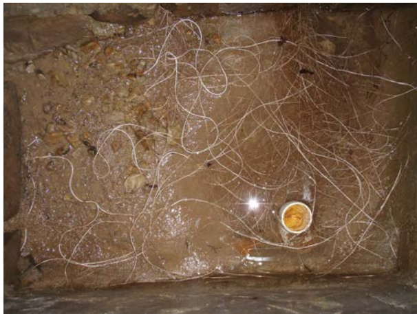
Photo 82: Nettoyage régulier indispensable pour éviter l'accumulation de racines et de solides dans la BC
