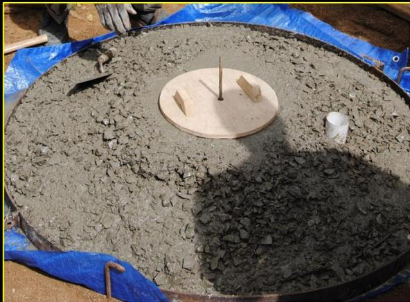
**B] Disposer le deuxième moule en bois :** c'est-à-dire celui qui sert de moule pour l'emplacement du siège-bokit. Ce deuxième moule vient recouvrir le moule en bois de la bouche latrine, il est placé de la même façon sur le piquet central.
