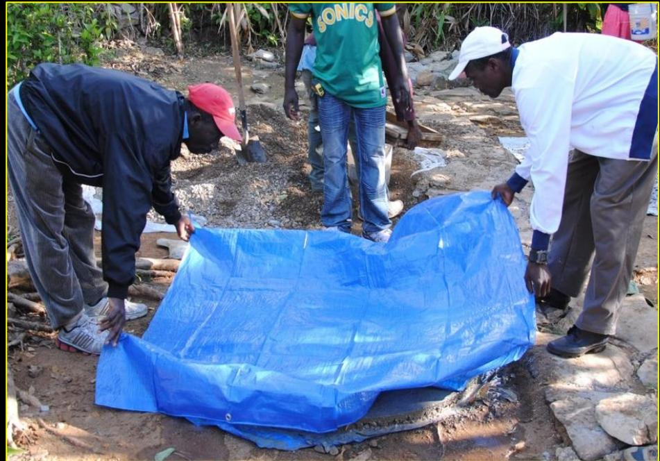
**A] Arroser la dalle :** à partir du jour suivant la construction et ce pendant 15 jours à un rythme de 3 fois par jour, arroser abondamment la dalle pour que le béton « boive » et ne se fissure pas. Cette étape est importante pour la solidité de la dalle.
