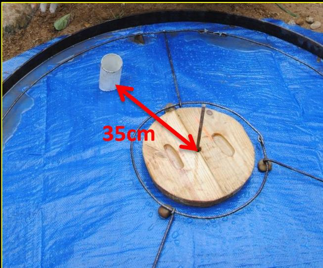
**B] Mesurer l'emplacement du tuyau :** le bout de tuyau découpé (7cm) doit être placé sur la pente du moule à une distance de 35cm depuis le piquet central. Maintenant **le moule est prêt !**
