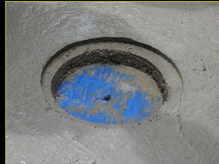
**A] Retirer le moule du siège-bokit :** avant que le béton durcisse il faut retirer les moules en bois, en commençant par celui du siège-bokit. Deux poignées sont prévues à cet effet sur le moule. Le retirer précautionneusement en tirant le long de l'axe donné par le piquet. Un premier cercle est formé dans la dalle : il servira à disposer un bokit renversé pour servir de siège à la latrine si le propriétaire de la dalle le juge utile.
