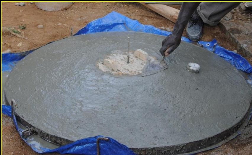
**A) Aplanir avec les taloches** : le kit outils propose 2 types de taloche, une standard et une spéciale pour dalle bombée. Pour utiliser cette dernière il faut poser une extrémité sur le rebord du moule en bois au sommet, la longueur de la taloche spéciale étant prévue pour couvrir le reste de la dalle jusqu'au rebord du moule en fer. Tapoter par petits coups consécutifs sur le ciment pour aplanir tous les rebords.
