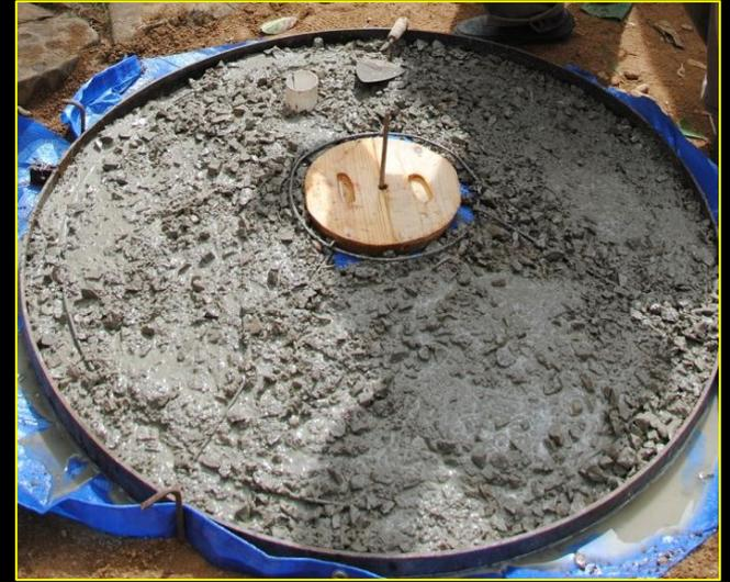
**A] Verser le mortier dans le moule :** veiller à ce que le bout de tuyau ne se déplace pas, se servir de la truelle pour diriger le béton tout autour. S'assurer que tous les espaces sont remplis et que le béton a la même épaisseur à chaque endroit. Il faut que le béton « prenne » bien autour du moule en bois de la bouche latrine : le recouvrir entièrement et retirer le surplus à l'aide d'une truelle.
