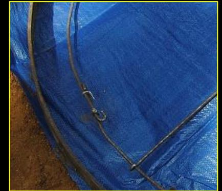
**B] Surélever le ferrailage :** une fois le ferrailage correctement disposé sur la forme bombée, il faut le surélever afin que le béton prenne tout autour des fers. Pour cela, placer des petites roches ou graviers à plusieurs endroits sous le ferrailage. Cette étape terminée, le moule est **presque** prêt.
