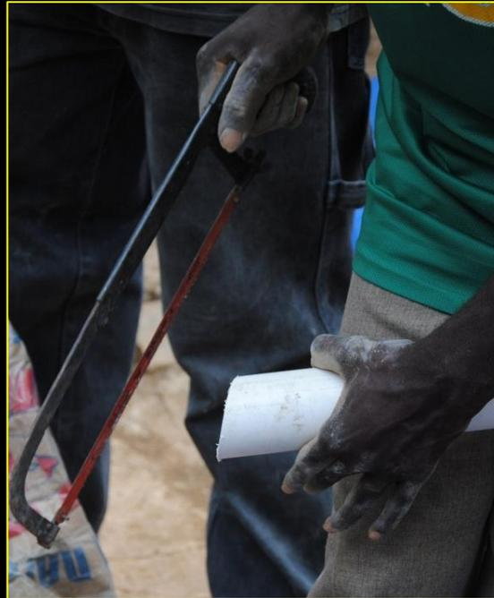
**A] Couper l'extrémité du tuyau :** le tuyau dans son intégralité n'est pas coulé dans le béton au moment de la construction de la dalle (il sera installé lors de la construction de l'abris-latrine). Il faut cependant ménager un emplacement spécial au moment de la construction. A 7cm (minimum) de l'extrémité basse du tuyau (mesure prise au mètre), scier en biseau un morceau du tube. Le reste du tube est conservé pour plus tard (abris latrine).
