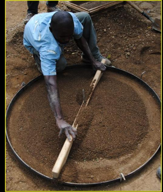
**A) Placer le moule en fer, le piquet et le moule en bois :** choisir un endroit bien plat, accrocher les deux parties du moule en fer avec le fil de fer, mesurer à l'aide du mètre le centre du cercle et y planter le piquet en fer  $\frac{1}{2}$  avec le marteau, installer le moule en bois sur le piquet et s'assurer qu'il puisse bien tourner sur lui-même sans gêne (terre, pierre, bosse...)
