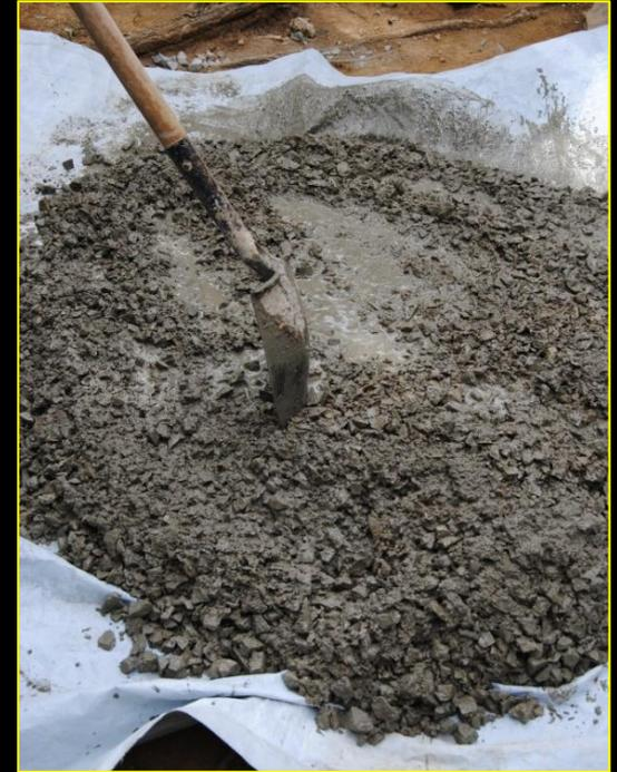
**A] Mélanger le sable, le gravier et le ciment :** les trois matériaux forment une pile d'un côté de la bâche. Il faut déplacer cette première pile, petit à petit, à l'aide d'une pelle pour bien mélanger les trois matériaux. Une fois que la première pile s'est déplacée pour former une deuxième pile de l'autre côté de la bâche, recommencer l'opération pour replacer le mélange à sa place initiale. Si le mélange n'est pas encore homogène, recommencer encore.
