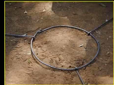
**C) Vérifier et essayer :** avant d'installer la structure, s'assurer que les cercles soient bien ronds et bien plats (pas de bosses dans le fer, chaque rebord touche le sol lorsque les cercles sont à terre). Positionner les rayons à distance raisonnable et les accrocher **sans forcer** aux deux cercles. Les crochets ne doivent pas être tournés dans la même direction !
