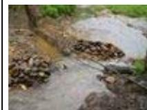
**Les fouilles doivent être effectuées sur une surface large. Augmenter la longueur des drains posés.**
