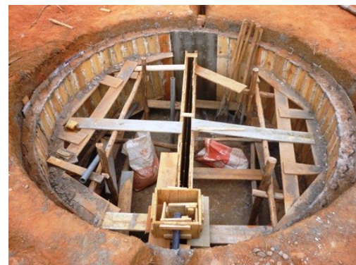
Réservoir à deux compartiments en construction
