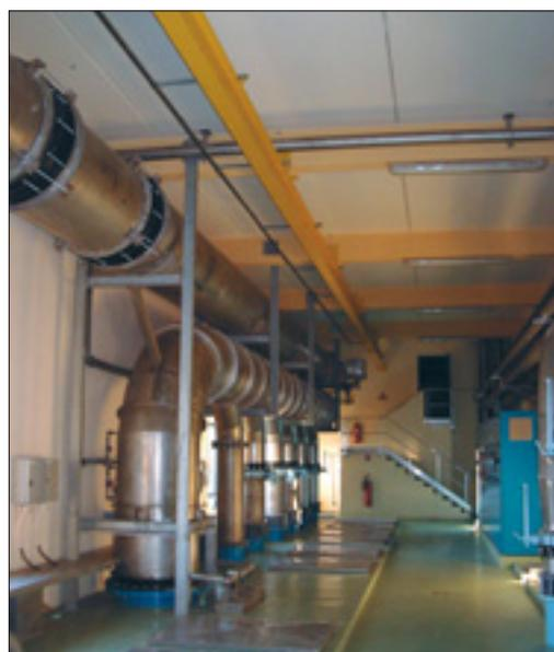
Photo 6 Rail de manutention placé au-dessus des trappes donnant accès aux pompes immergées.
