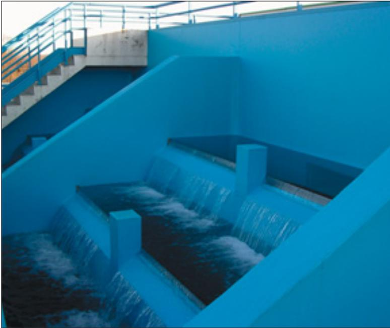
Photo 8 Cascade d'eau potable avant distribution dans le réseau.
