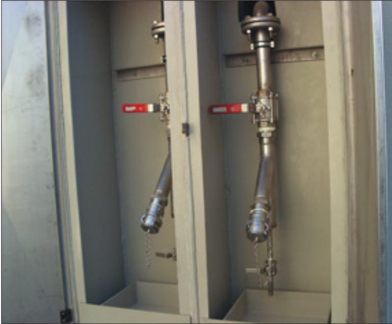
Photo 9 Dispositif de dépotage avec rétention.
