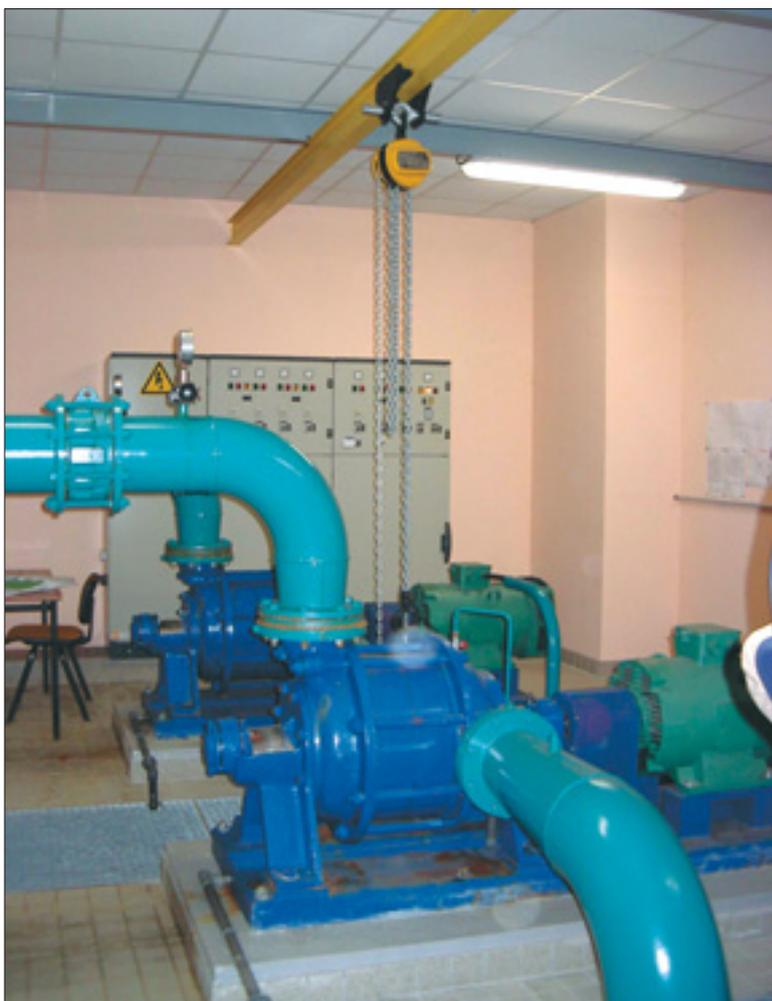
Photo 2 Rail de manutention avec chariot et palan au-dessus des pompes de distribution.
