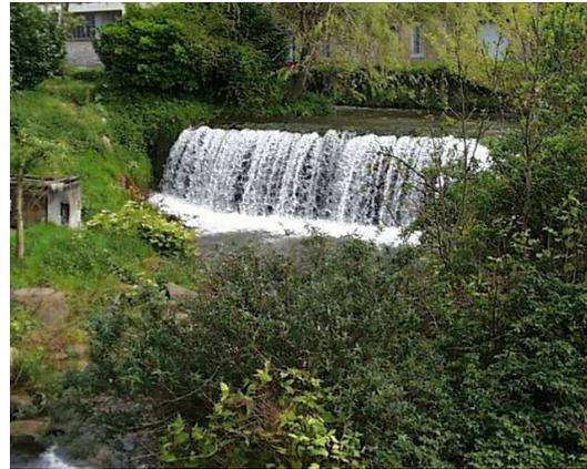
FIGURE 6.9 – Seuil en rivière (section de contrôle)
