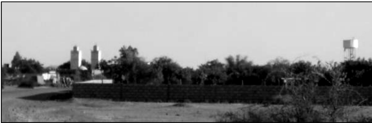
Figure 14 : Le nouveau château d'eau de Tuabu vu depuis l'entrée du village.
