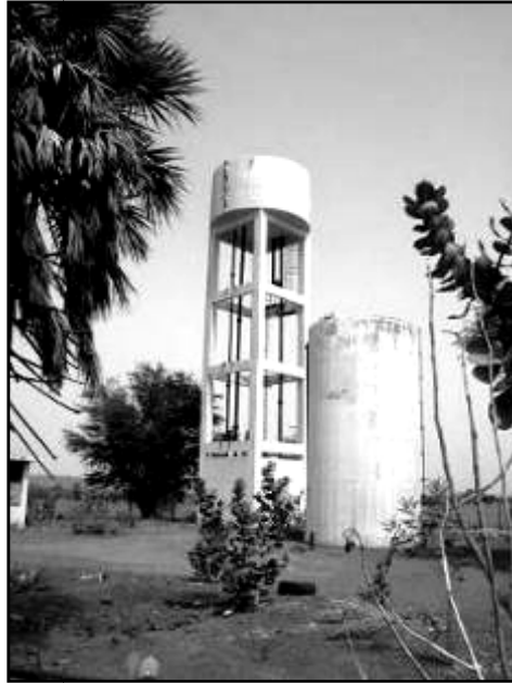
Figure 13 : Le « petit » château d'eau de Tuabu, réalisé en 1992 (premier plan, posé au sol), et le nouveau château (à l'arrière plan)
