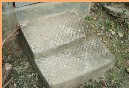
Degraus baixos, com sulcos cruzados para serem menos escorregadios quando estão molhados, Nepal. Fotografia: Jones et al. 2009.
