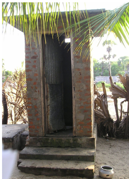
Casa de banho com degraus altos e porta estreita, Batticaloa, Sri Lanka. Fotografia: WEDC/ Hazel Jones.
