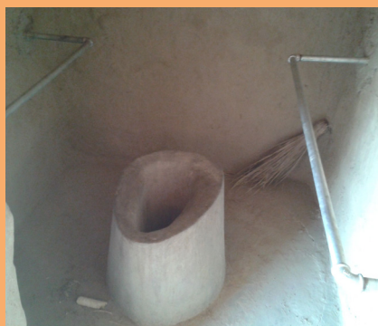
Sanita fixa com corrimão. O corrimão pode ser feito de madeira para reduzir os custos. Fotografia: WaterAid/Jane Wilbur.
